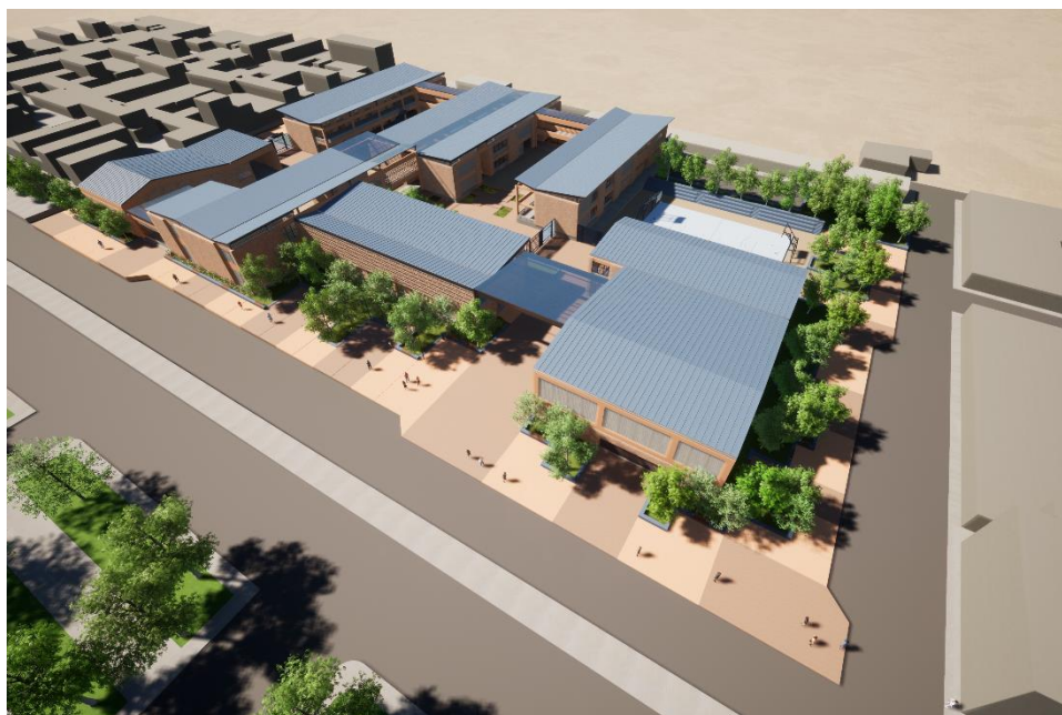
Figura 66: Vista área del colegio. Fuente: Propia
