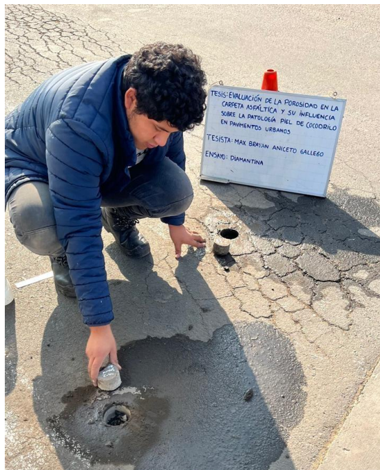
Ilustración 17 Extracción de muestras en la calle Santa Rosa.
