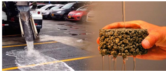
Ilustración 2 Porosidad en el pavimento [34].
