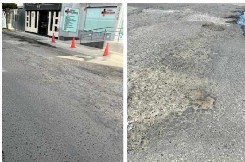
Ilustración 9 Visita a la calle 7 de Enero Sur.
