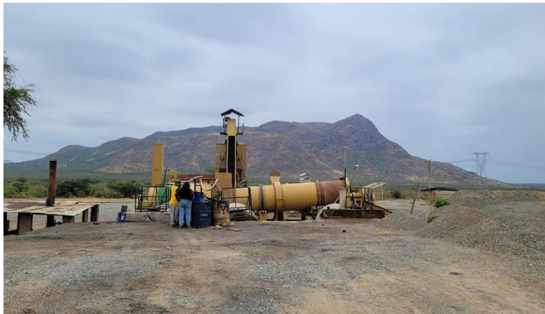
Ilustración 1. Visita Planta de Asfalto del Gobierno Regional de Lambayeque
