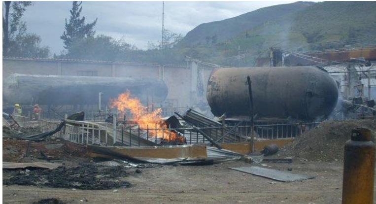
Figura N° 24 Explosión de Planta envasadora
