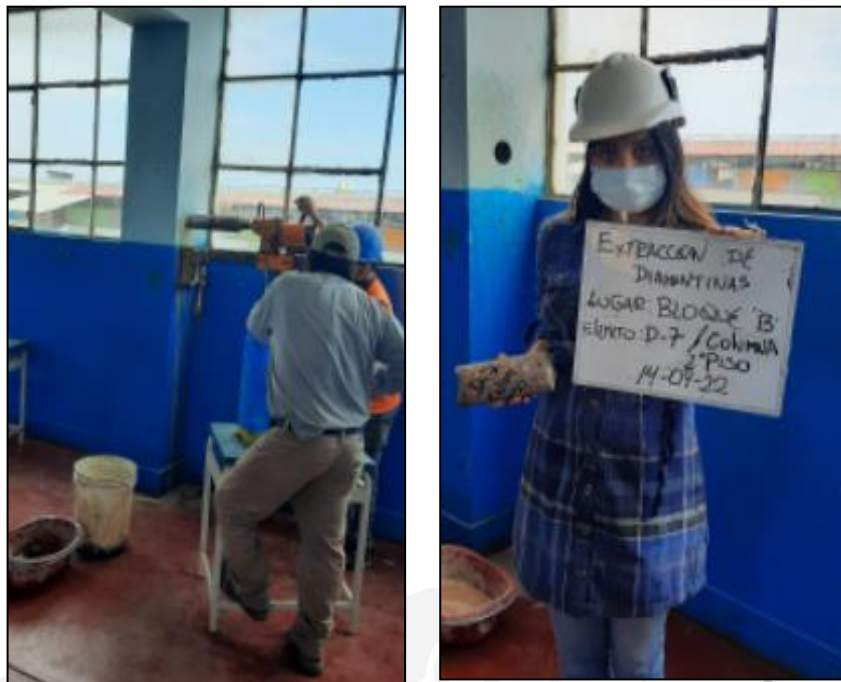
Figura 14: Extracción de la muestra D-7– Bloque B
