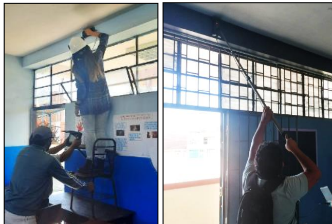
Figura 10: Escaneo del acero de la viga (X1)
