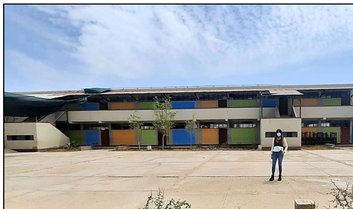
Figura 22: Fachada interior del módulo A
