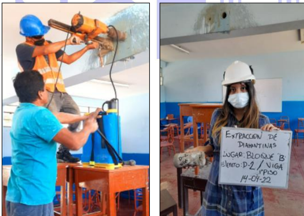
Figura 13: Extracción de la muestra D-2– Bloque B
