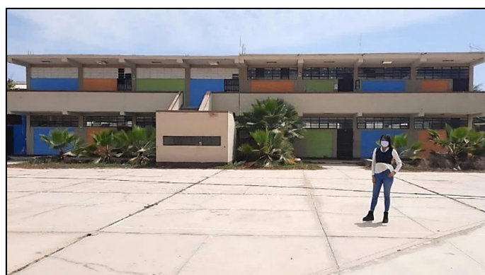
Figura 23: Fachada interior del módulo B
