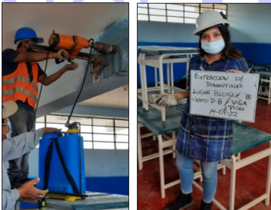
Figura 15: Extracción de la muestra D-8– Bloque B
