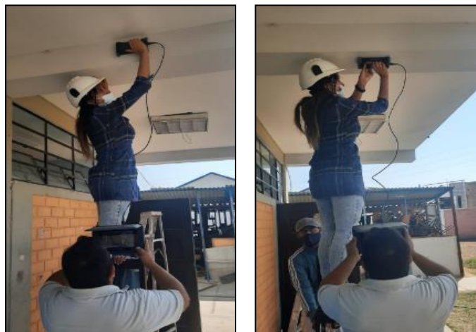
Figura 13: Escaneo del acero de la viga (Y3)
