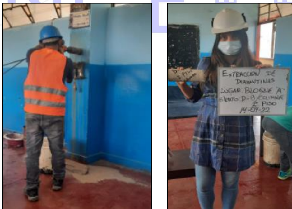
Figura 11: Extracción de la muestra D-8– Bloque A
