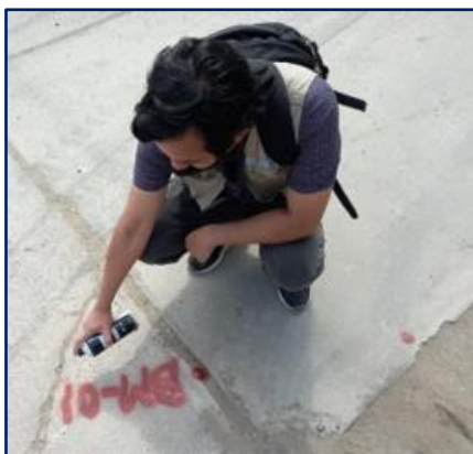
Figura 03 Marcado del BM-01
