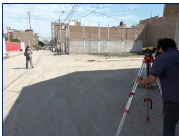
Figura 04 Realización de la nivelación geométrica
