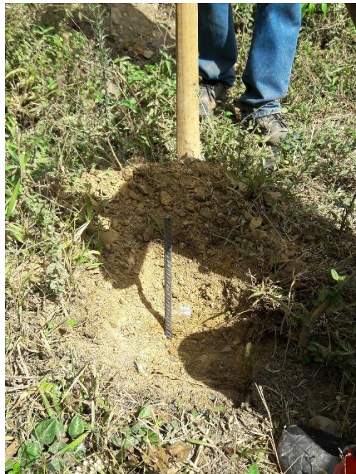
FOTOGRAFIA N°7.4. Procedimientos de monumentación de BMs
