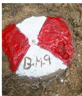
Ilustración 17. Hito de concreto BM9
