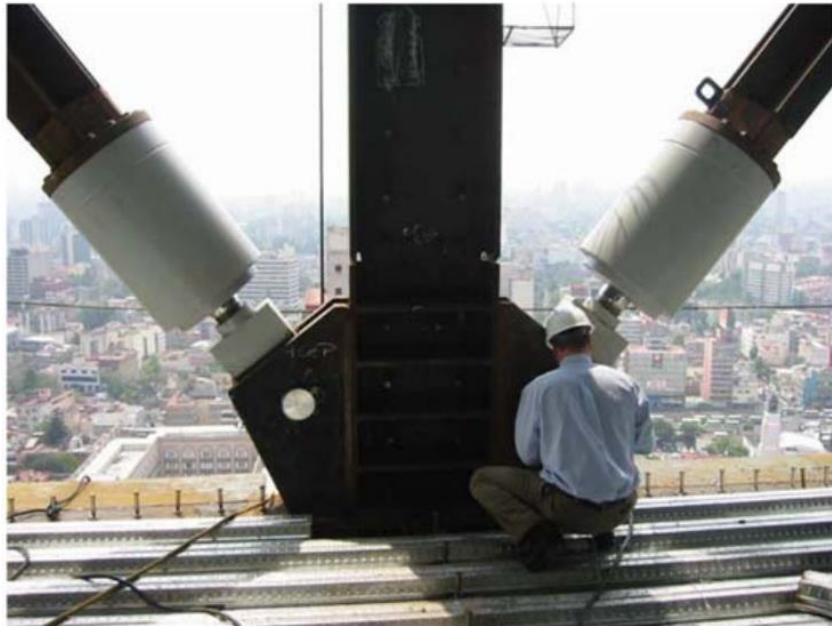
Ilustración 48: Edificio Torre Mayor con disipadores Taylor (Foto cortesía de Enrique Martínez Romero, Tena-Colunga 2003)
