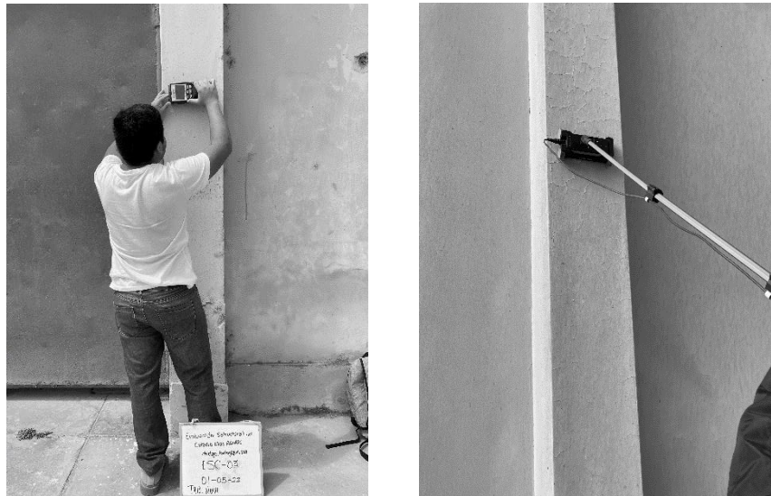
Figura 66: Ensayo de Escáner en la Tribuna Norte. Toma E-3
