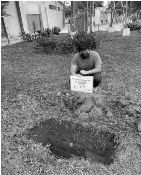
Figura 89: Excavación de la Calicata N°3
