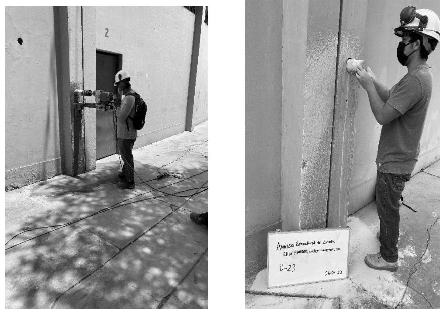
Figura 59: Perforación y Extracción del D23
