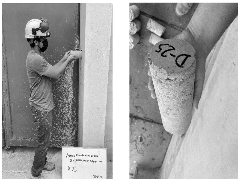
Figura 61: Perforación y Extracción del D20
