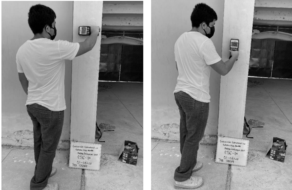
Figura 85: Ensayo de Escáner en la Tribuna Oriente. Toma E-4
