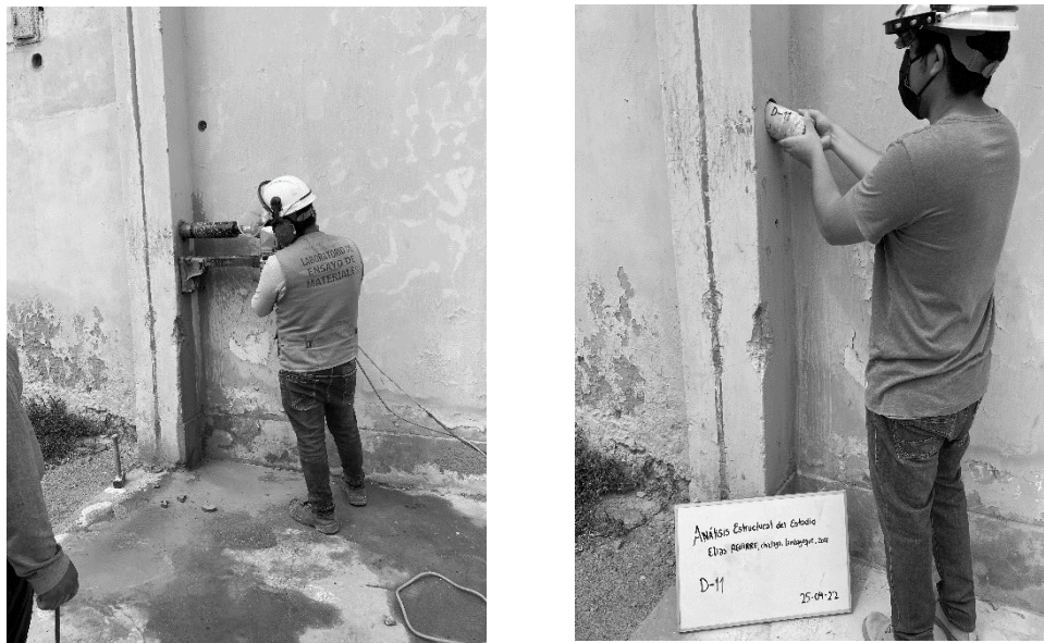
Figura 45. Perforación y Extracción del D11
