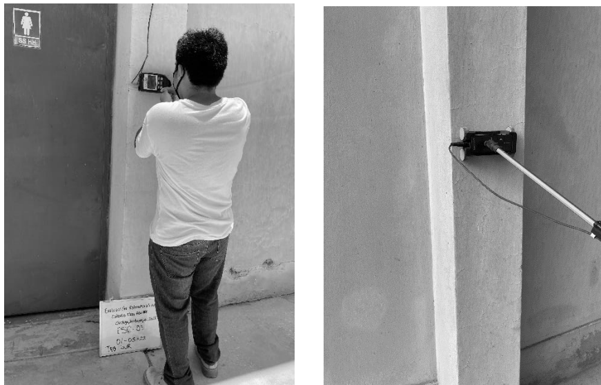
Figura 80: Ensayo de Escáner en la Tribuna Sur. Toma E-5
