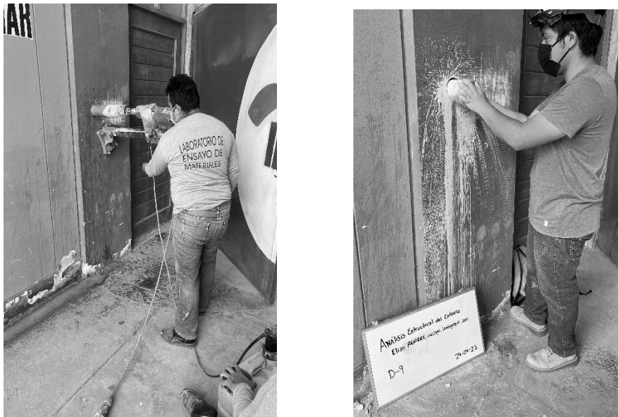
Figura 42. Perforación y Extracción del D9
