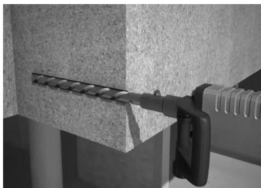
Paso 1: Perforación del elemento estructural con un taladro rotopercutor
