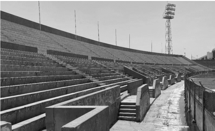
Figura 19: Vista General de la Tribuna Oriente
