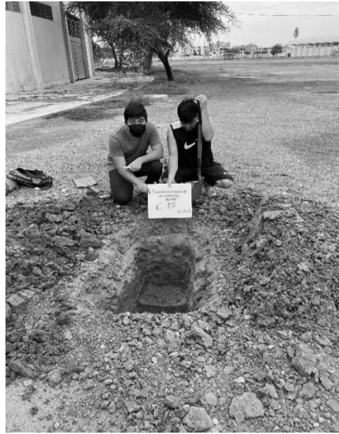
Figura 91. Excavación de la Calicata N°2
