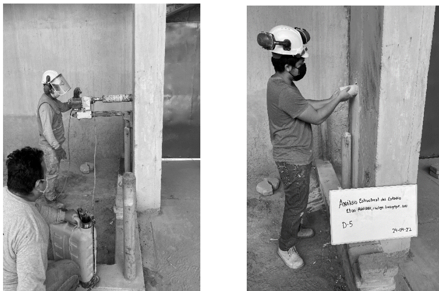
Figura 38. Perforación y Extracción del D5
