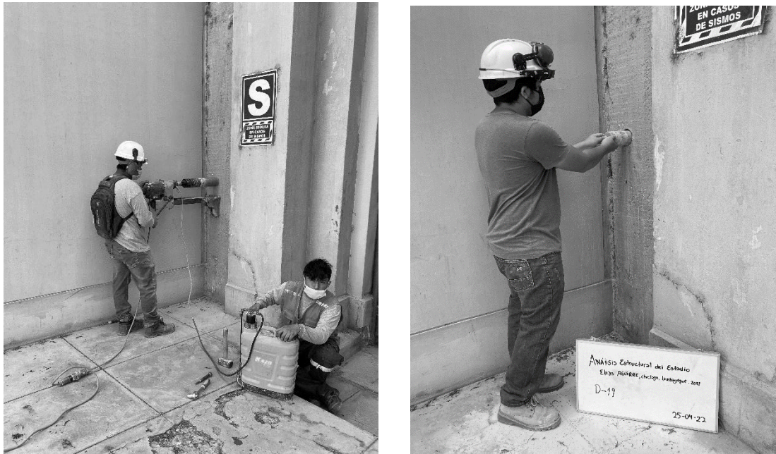
Figura 54. Perforación y Extracción del D19
