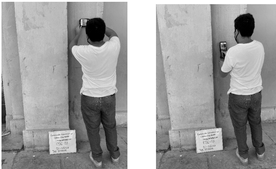
Figura 72: Ensayo de Escáner en la Tribuna Occidente. Toma E-3
