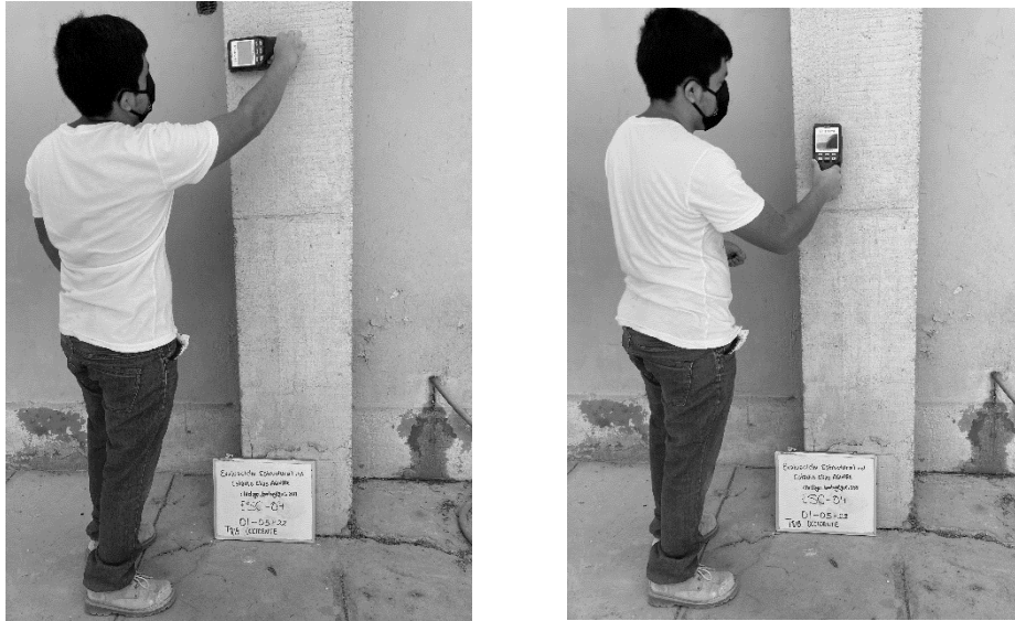
Figura 73: Ensayo de Escáner en la Tribuna Occidente. Toma E-4
