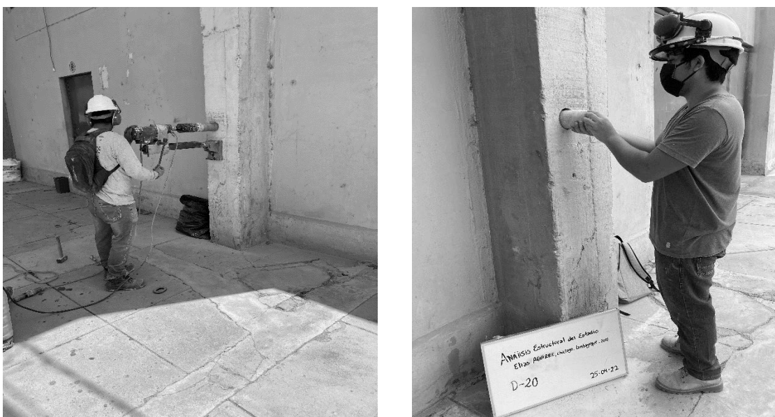
Figura 55. Perforación y Extracción del D20
