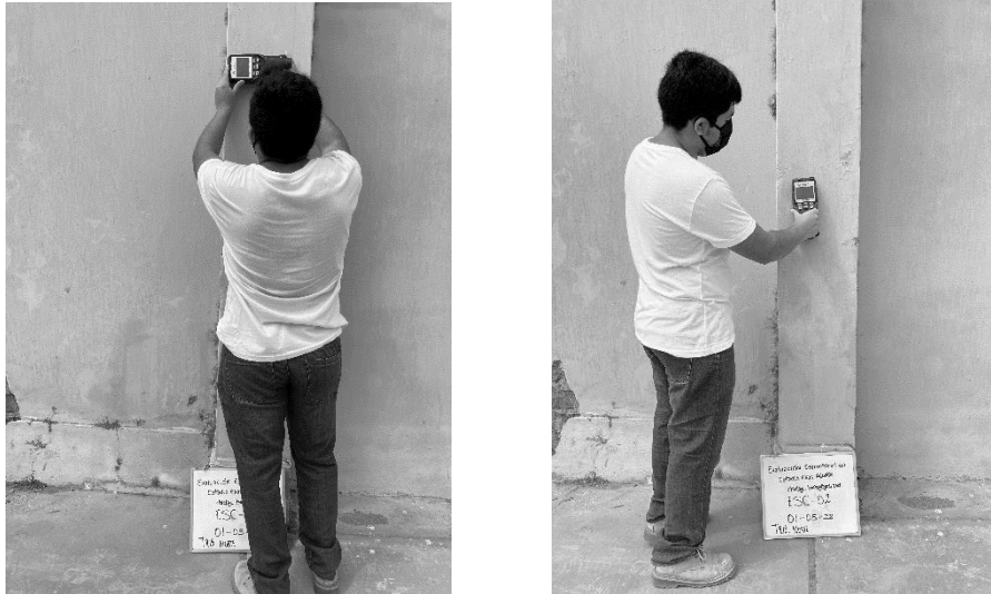
Figura 65: Ensayo de Escáner en la Tribuna Norte. Toma E-2
