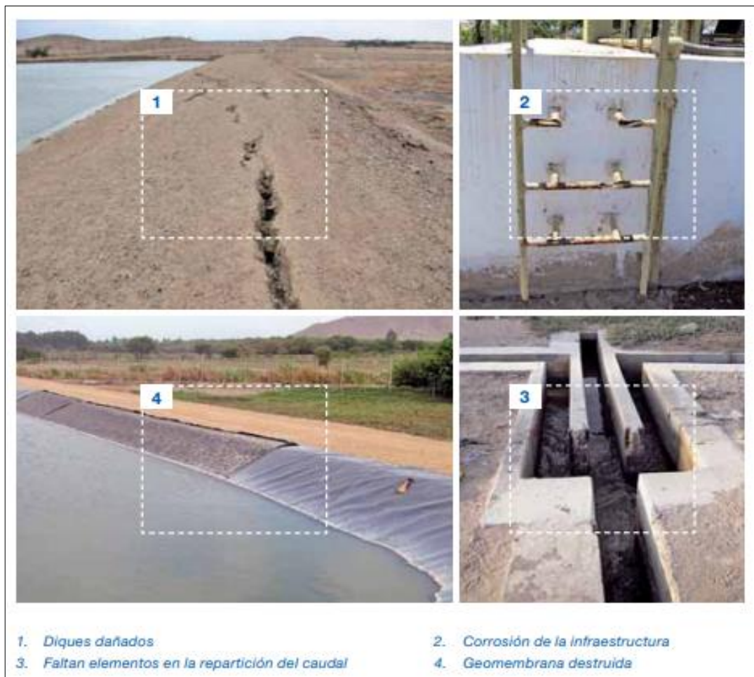
Ilustración 31. Observaciones típicas respecto a la operación y mantenimiento de los componentes de una PTAR (Fuente: [2]).
