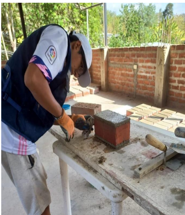
Anexo 11: Limpieza de restos de mortero en los ladrillos Fuente: Elaboración propia
