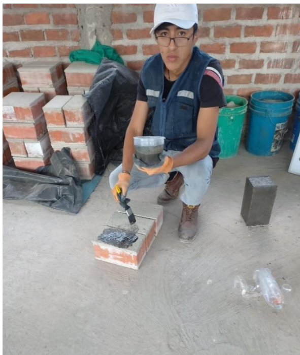
Anexo 15: Colocación de la mezcla sobre los ladrillos sin tarrajear
