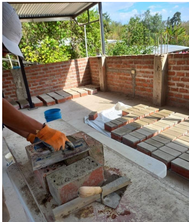
Anexo 10: Colocación del mortero en los ladrillos Fuente: Elaboración propia
