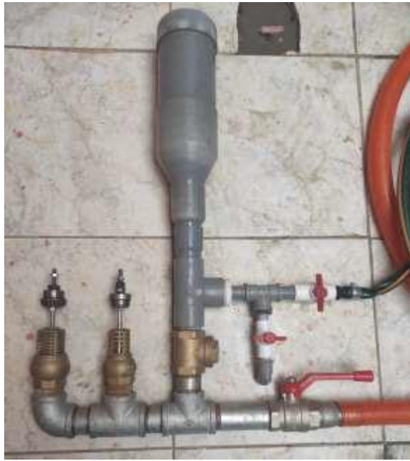
Figura 41 Montaje del cuerpo de la bomba de ariete
