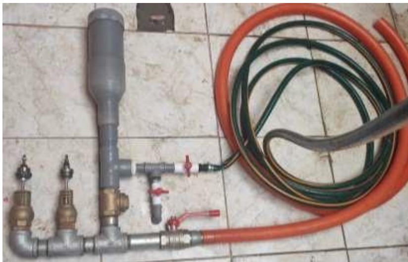
Figura 42 Montaje de la bomba de ariete con ducto de alimentación y descarga
