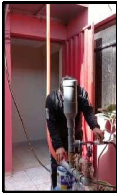
Figura 44 bomba de ariete en funcionamiento
