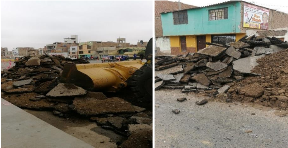
Ilustración 2 Remoción de carpeta asfáltica en las intersecciones de la Av. Chinchaysuyo y Av. Antenor Orrego. Fuente: Propia
