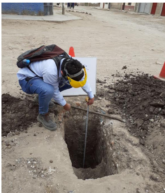
Figura 3.2 Calicata 01, intersección calle Atahualpa y Panamá
