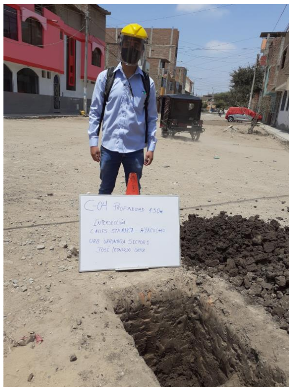
Foto N° 4.4 Calicata 04 – calle Sta. Martha y Ayacucho
