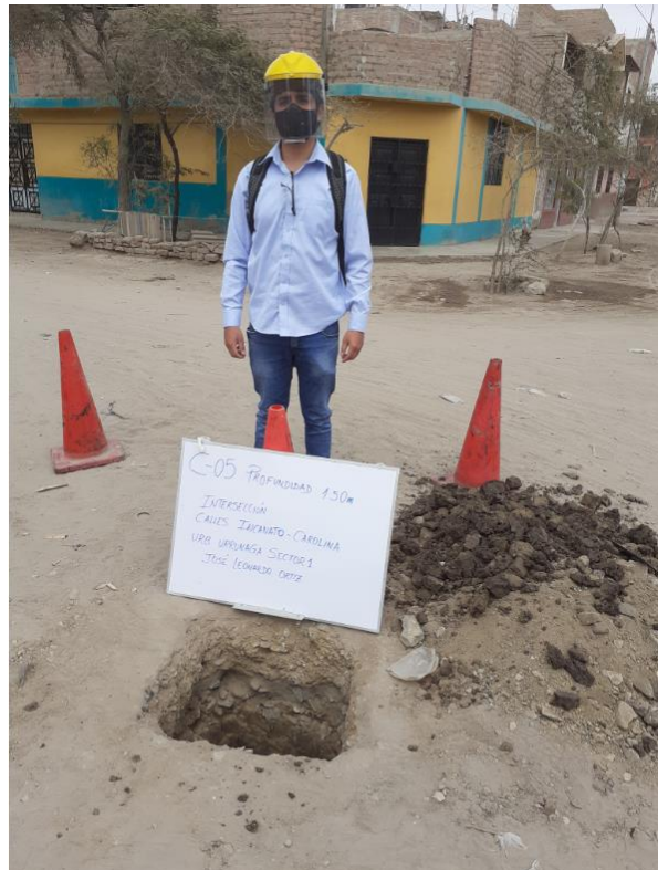
Foto N° 4.5 Calicata 05 – calle Carolina e Incanato
