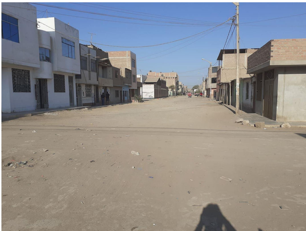
Foto No 2.5: Estado actual de la calle Carolina
