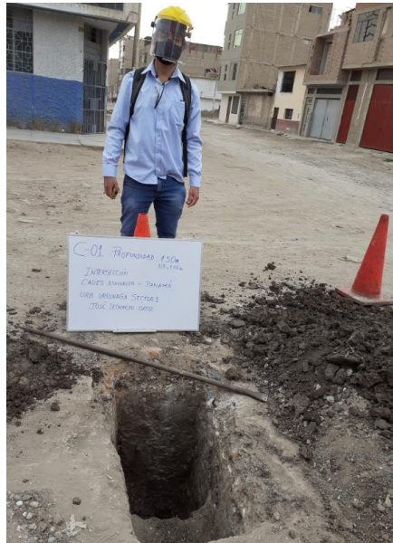
Figura 3.3 identificación de la calicata 01
