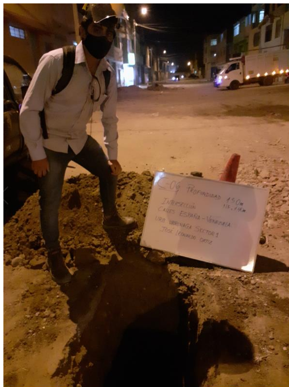
Foto N° 4.6 Calicata 06 – calle España y Venezuela
