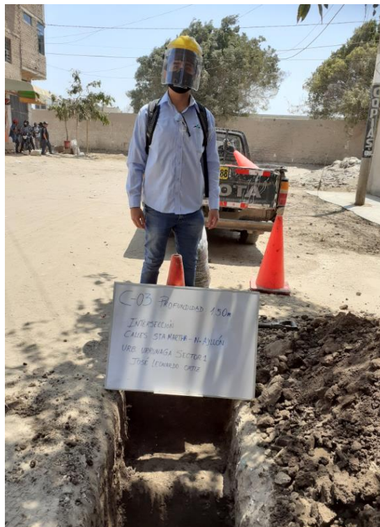
Foto N° 4.3 Calicata 03 – calle Sta. Martha y Nicolás Ayllon
