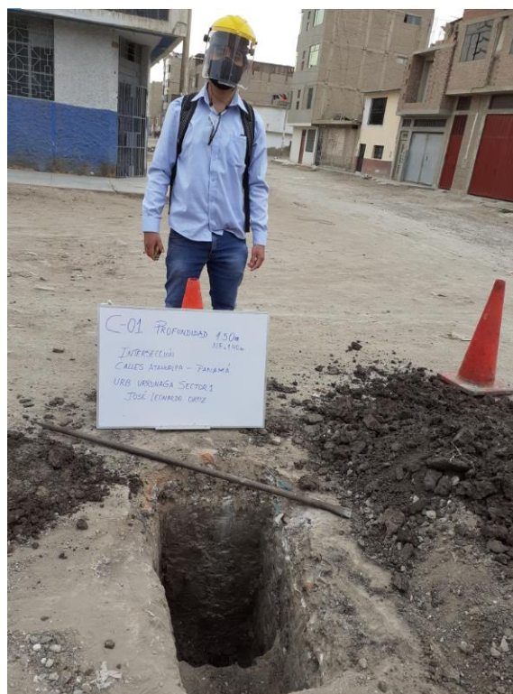
Foto N° 4.1 Calicata 01 – calle Atahualpa y Panamá
