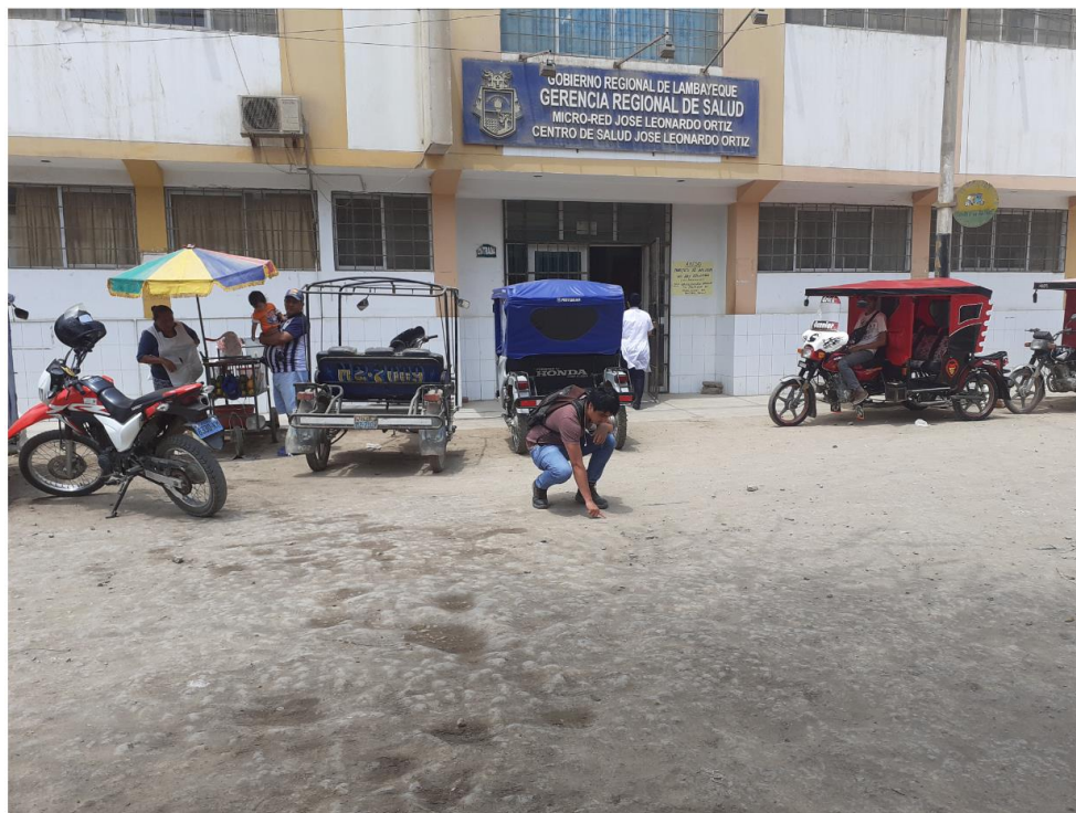
Foto No 2.7: Estado actual de la calle Húsares de Junín
