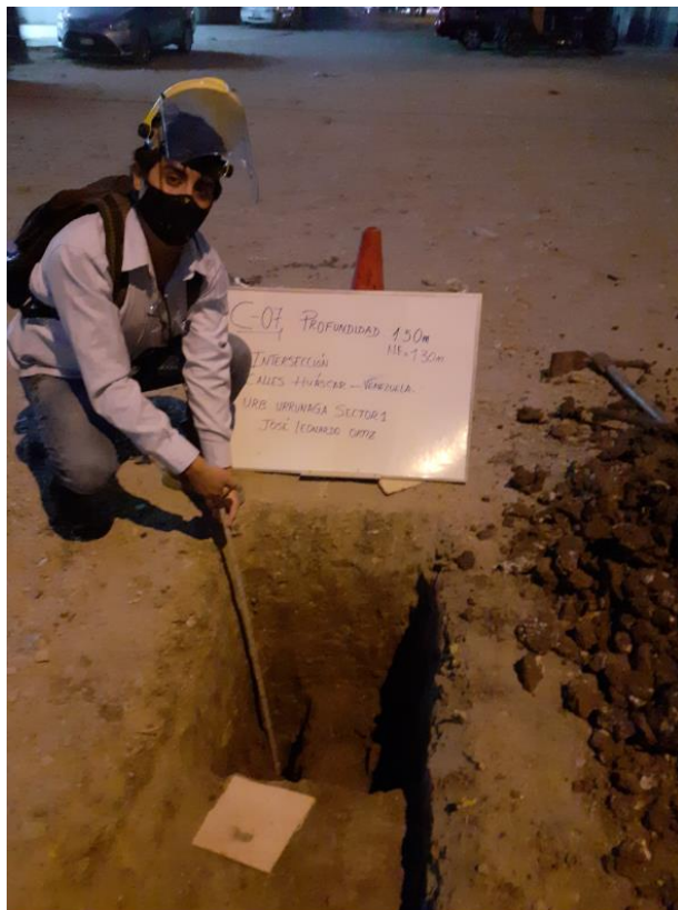
Foto N° 4.7 Calicata 07 – calle Huáscar y Venezuela
