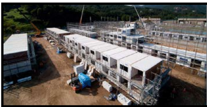
Ilustración 1.-Sistema de contenedores apilados
