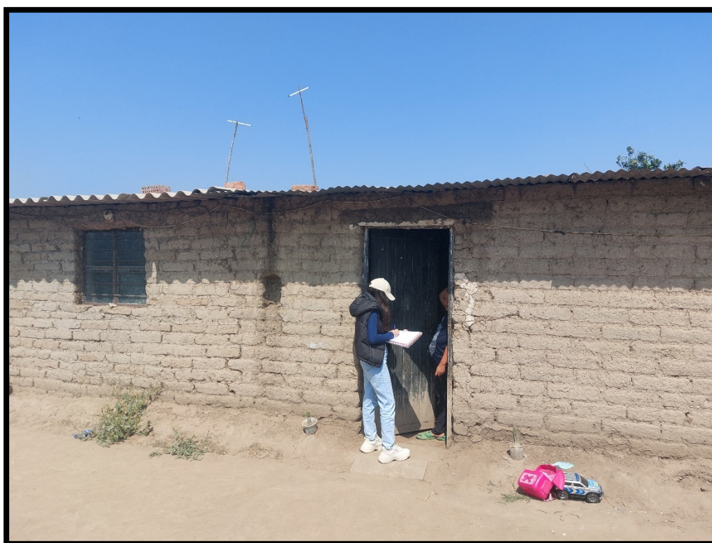
Ilustración 81-. Encuestas - Vivienda de material Adobe - Riesgo Inundación - Vulnerabilidad Muy Alta
