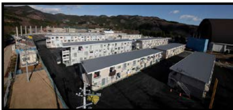
Ilustración 2.- Área de Viviendas provisionales usando sistema de contenedores
