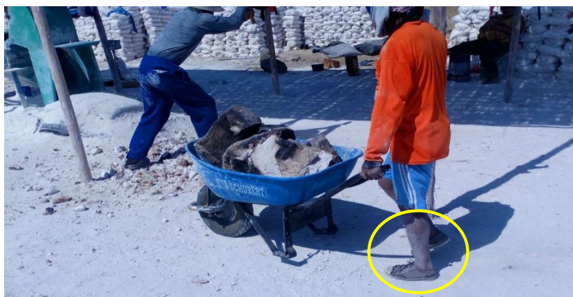
Figura 18. Traslado de yeso de construcción Fuente: Empresa yesera
