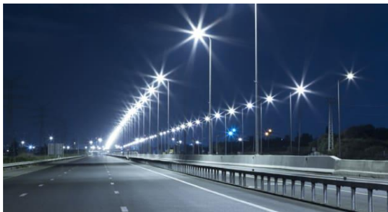
Fig. 1 Sistema de Alumbrado Público
