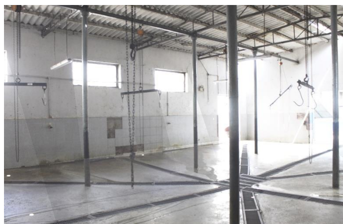
Figura 13 Iluminación en el edificio Camal Municipal de Ferreñafe. Elaboración Propia
