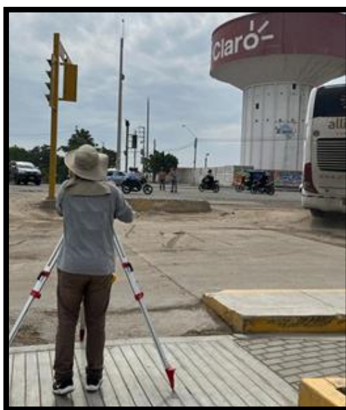
Ilustración 50: Levantamiento topográfico en intersección
