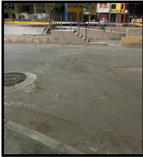
Ilustración 55: Paso peatonal en Av. Víctor Raúl Haya de la Torre
