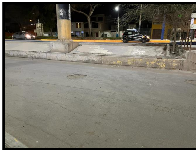
Ilustración 57: Señalización horizontal en Av. Víctor Raúl Haya de la Torre
