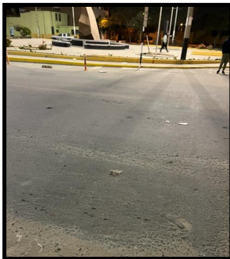
Ilustración 58: Señalización horizontal en Av. Chinchaysuyo
