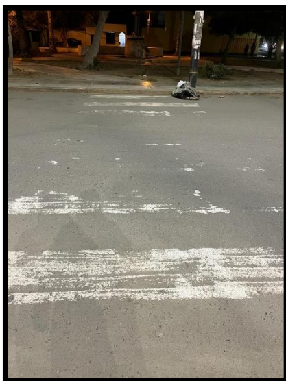
Ilustración 54: Paso peatonal en Av. Chinchaysuyo
