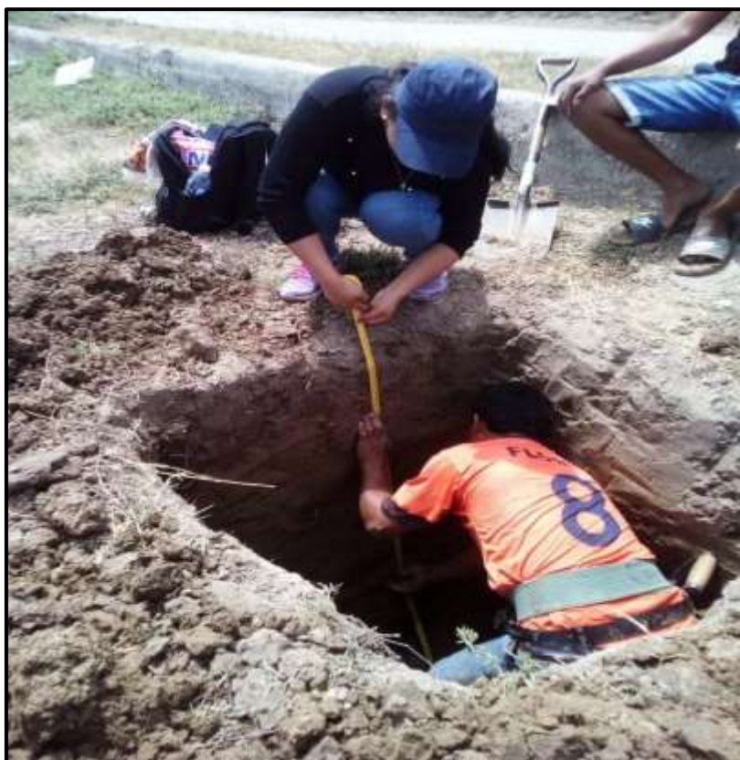
FOTOGRAFÍA N° 2.12: Excavación de la calicata 8.
