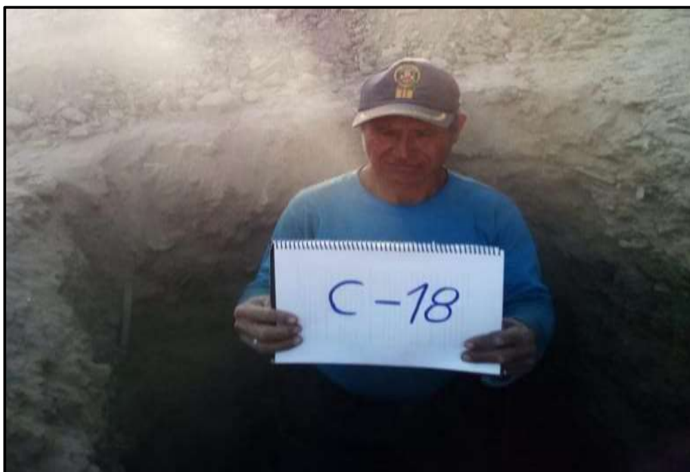
FOTOGRAFÍA N° 2.11: Excavación de la calicata 18.
