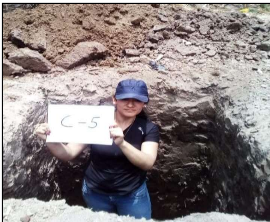
FOTOGRAFÍA N° 2.9: Excavación de la calicata 5
