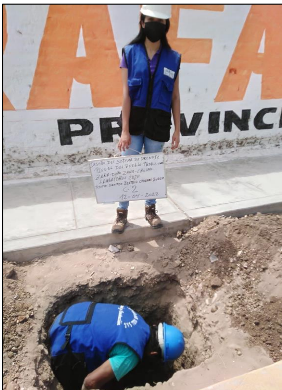
Figura 9. 9: Excavación de calicata N°02
