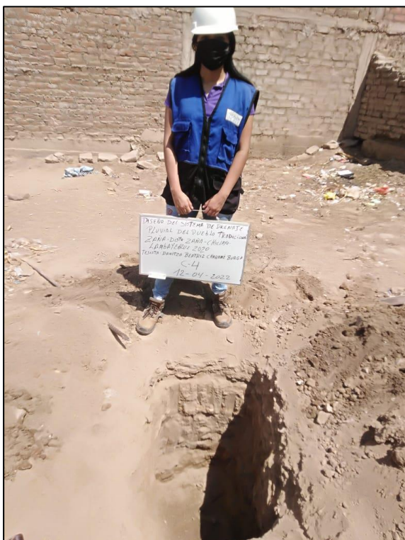
Figura 9. 7: Excavación de calicata N°04
