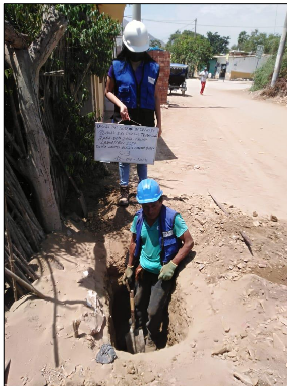
Figura 9. 8: Excavación de calicata N°03
