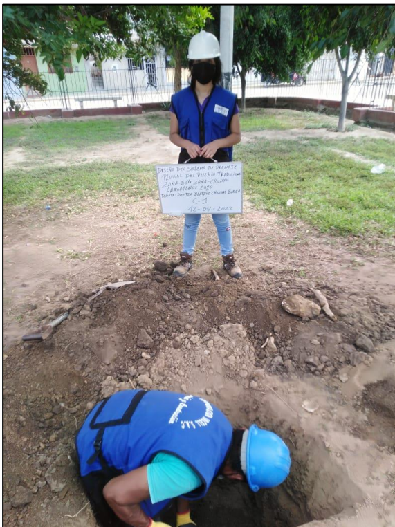
Figura 9. 5: Excavación de calicata N°01
