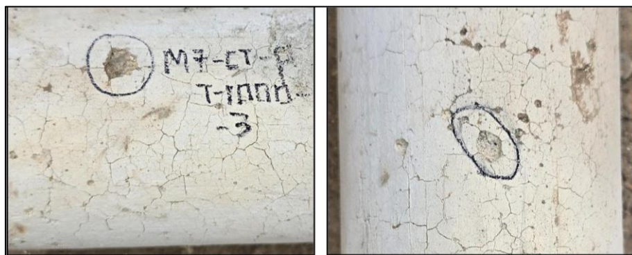
Fig. 64 y 65. Spalling en muestra M7-CT-P y M6-CT-P
