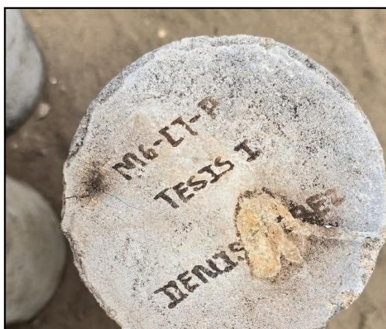
Fig. 76. Manchas en el concreto en M6-CT-P
