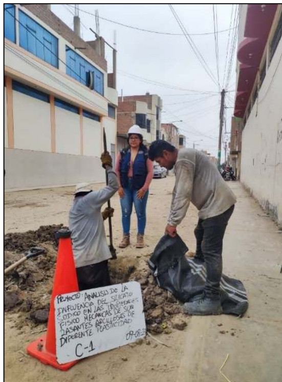
Ilustración 12: Ejecución en campo de calicatas
