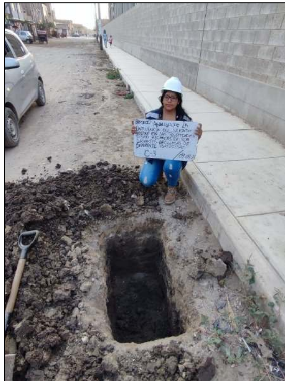
Ilustración 11: Obtención Calicata N°03
