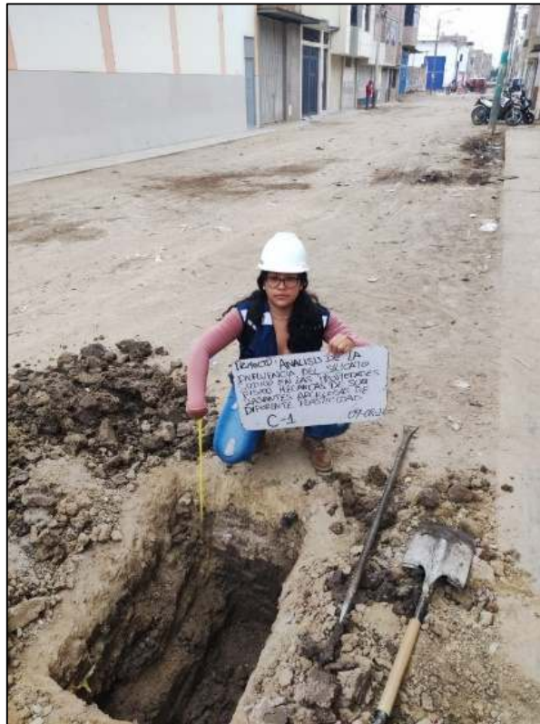
Ilustración 9: Obtención de Calicata N°01
