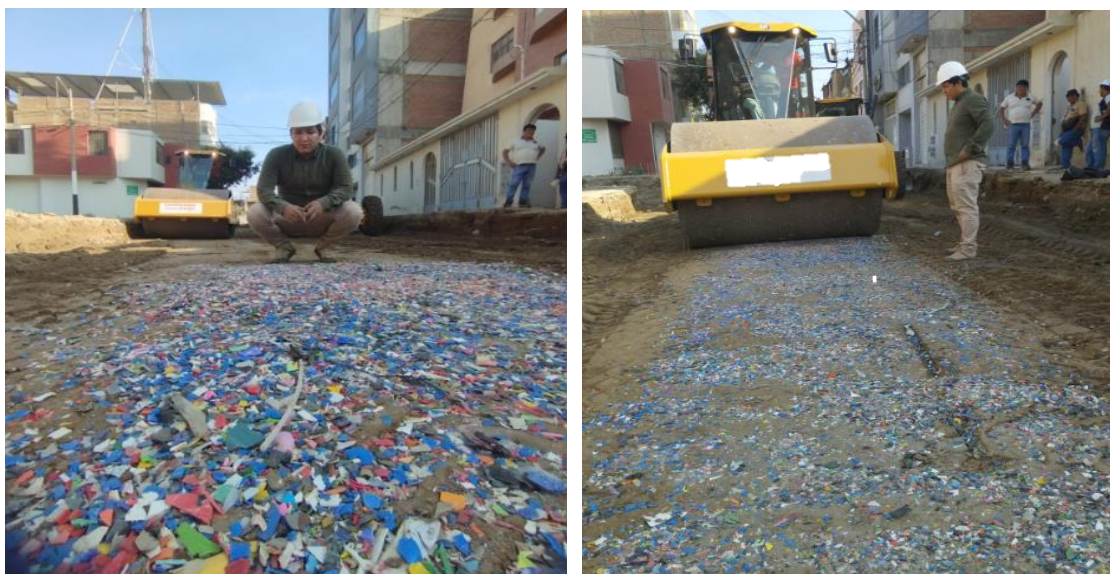
Ilustración 26: Partida de compactación de la subrasante con HDPE.
