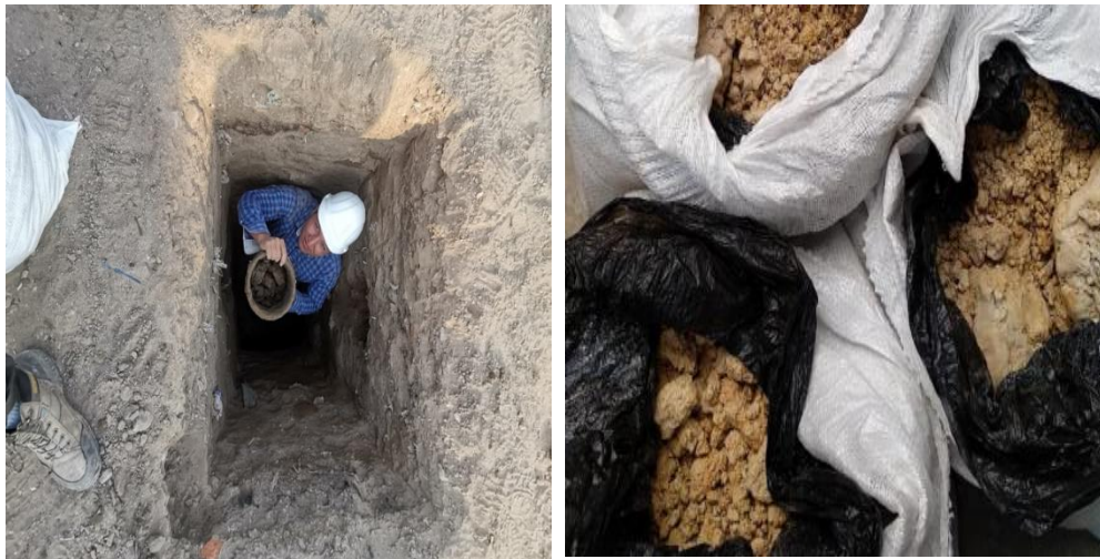
Ilustración 14: Calicata C-03 a 1.65m de profundidad
