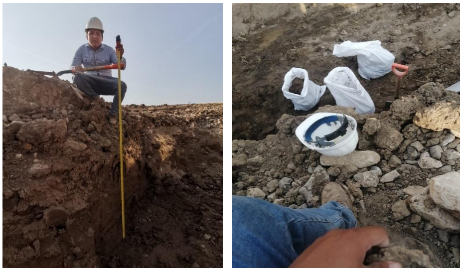
Ilustración 12: Calicata C-01 a 1.70 m profundidad
