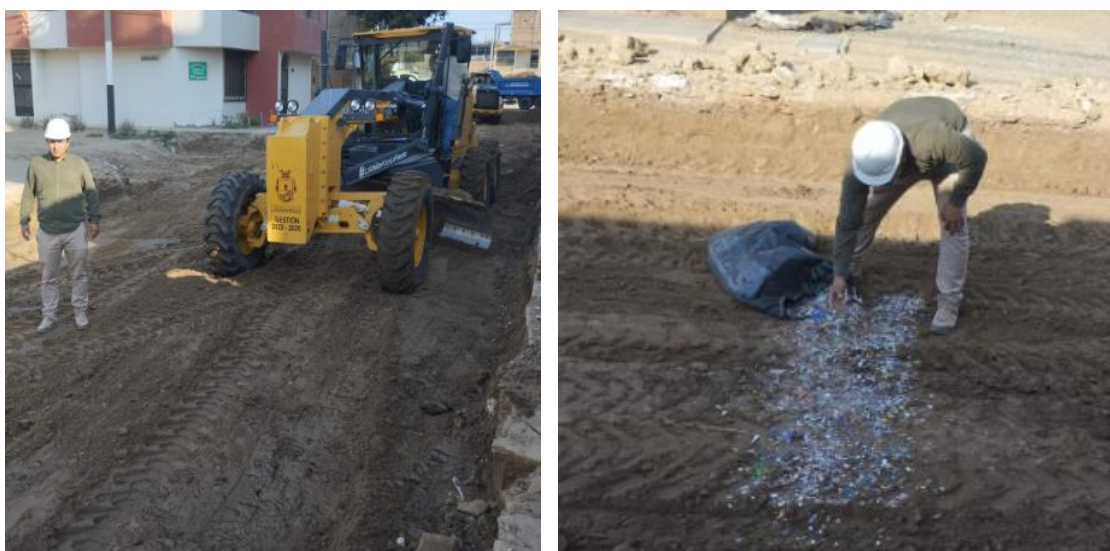
Ilustración 25: Partida de excavación y expansión del HDPE en el suelo.
