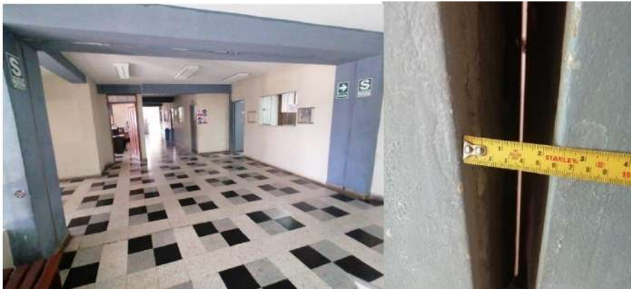
H) Junta sísmica entre el bloque C y D
