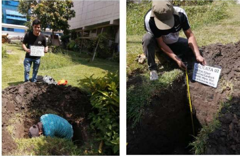
Ilustración 3. Excavación de la Calicata 03
