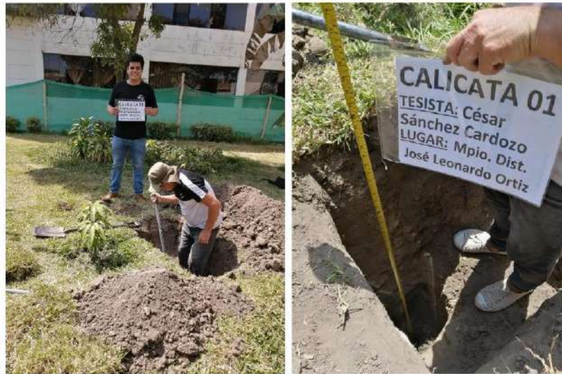
Ilustración 2. Excavación de la Calicata 01
