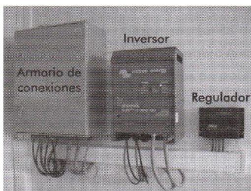
Figura 10. Protecciones de una instalación fotovoltaica [20].
