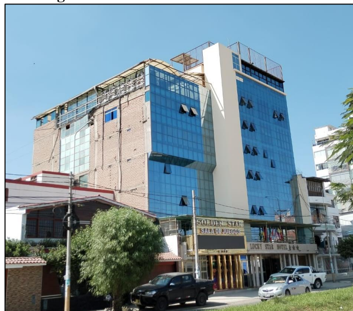
Figura 23. Vistas de las fachadas soleadas.
