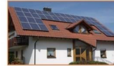
Aislada sistema solar casero
