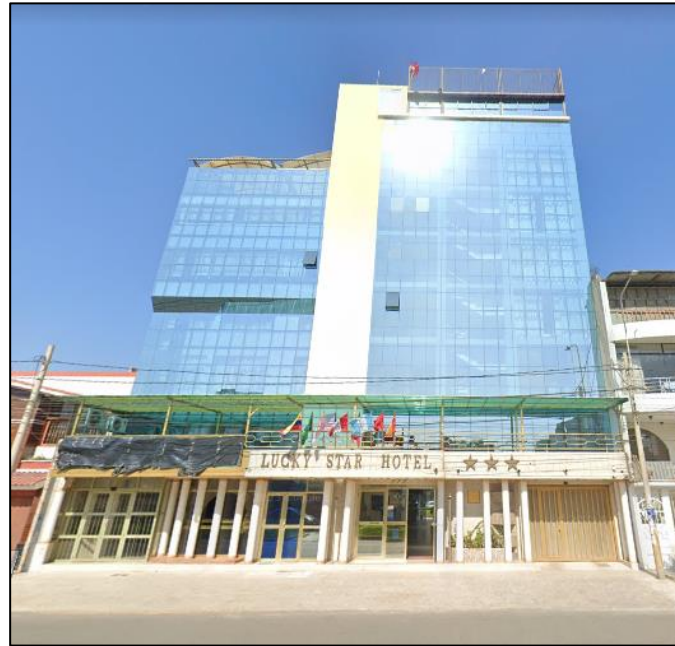
Figura 22. Fachada del edificio del Hotel.
