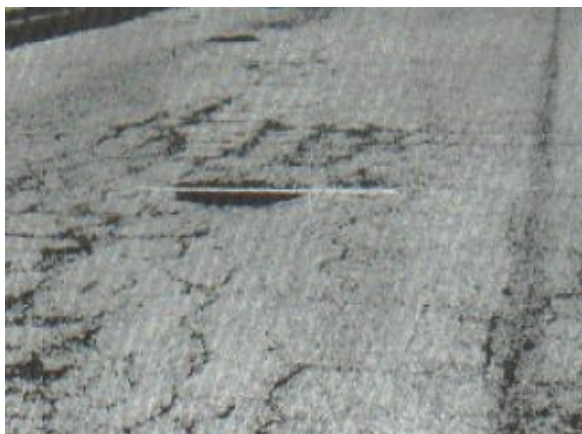
Ilustración 36. Huecos -Media severidad.
