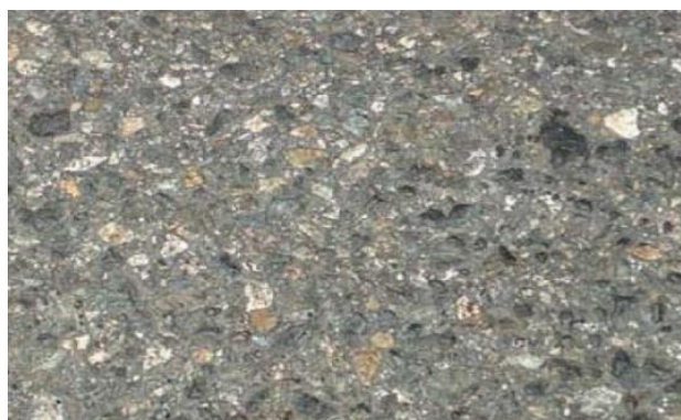
Ilustración 33. Pulimento de agregados.
