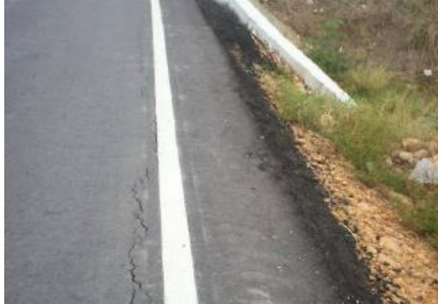
Ilustración 21. Fisuras de borde - Media severidad.
