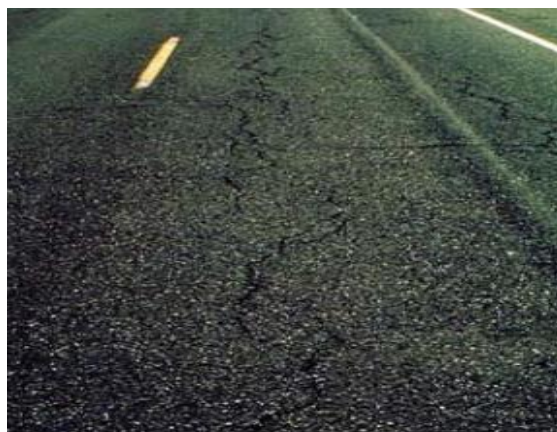
Ilustración 28. Fisuras longitudinales y transversales - Media severidad.
