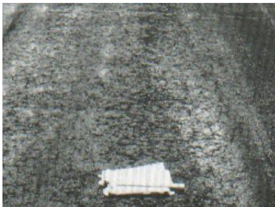
Ilustración 52. Ahuellamiento - Alta severidad.
