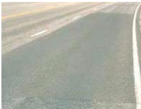
Ilustración 30. Baches y zanjas reparadas -Baja severidad.
