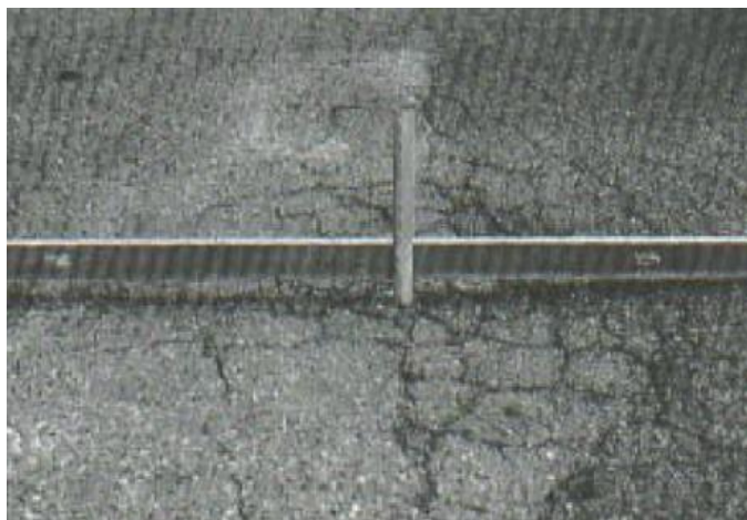
Ilustración 19. Depresiones - Alta severidad.
