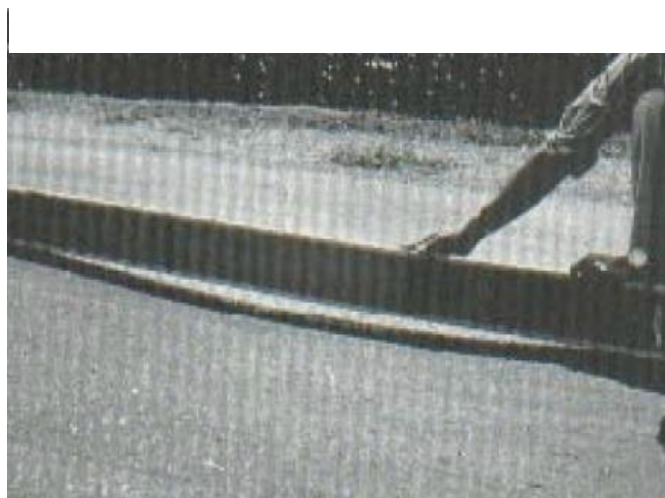
Ilustración 19. Depresiones - Alta severidad.
