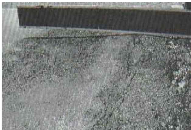
Ilustración 13. Abultamientos y hundimientos -Alta severidad.
