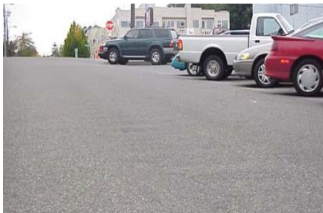
Ilustración 14. Corrugaciones -Baja severidad
