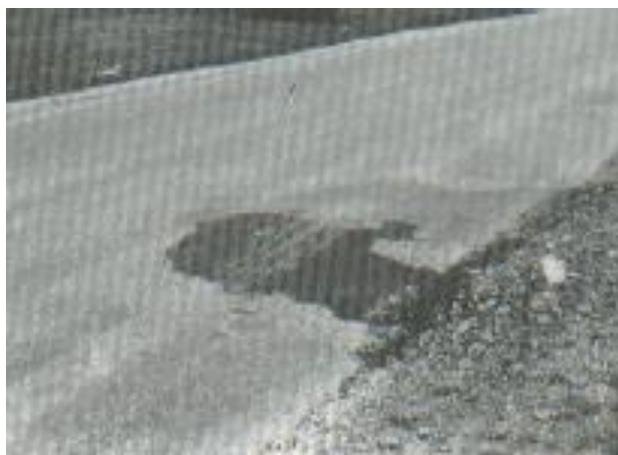
Ilustración 32. . Baches y zanjas reparadas - Alta severidad.
