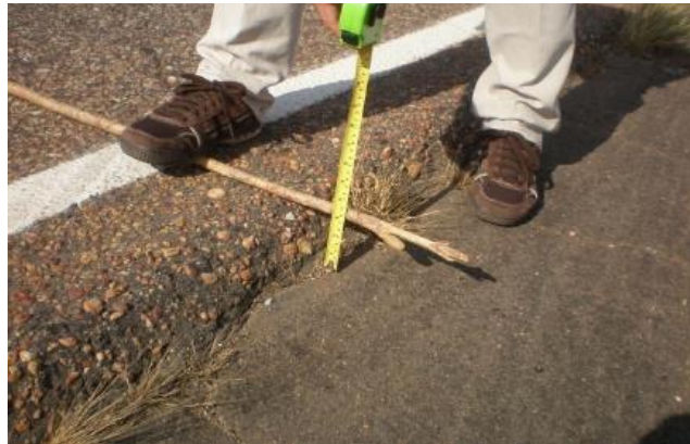
Ilustración 26. Grieta de reflexión de juntas - Alta severidad.
