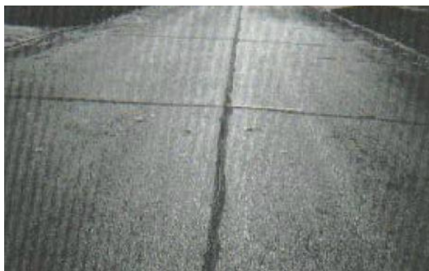
Ilustración 23. Grieta de reflexión de juntas -Media severidad.
