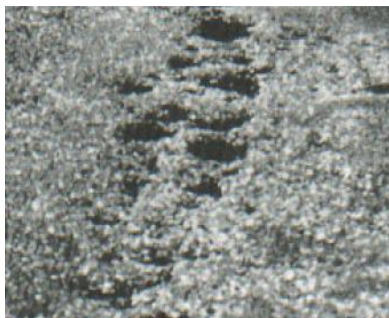
Ilustración 52. Ahuellamiento - Alta severidad.
