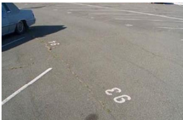
Ilustración 23. Grieta de reflexión de juntas -Media severidad.
