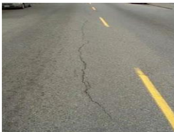
Ilustración 28. Fisuras longitudinales y transversales - Media severidad.
