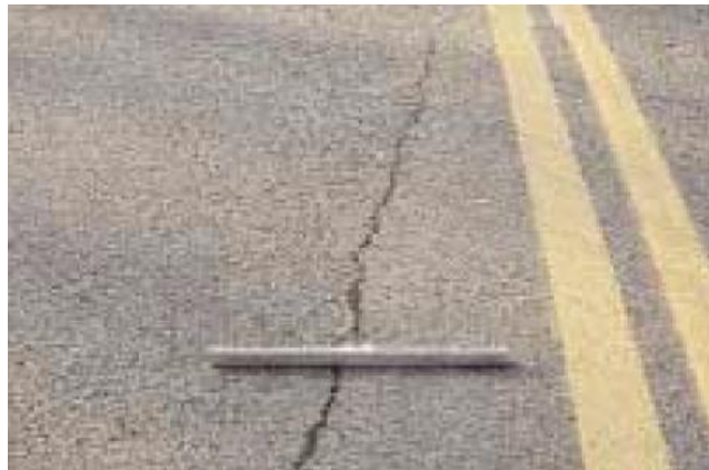
Ilustración 21. Fisuras de borde - Media severidad.
