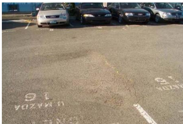
Ilustración 13. Abultamientos y hundimientos -Alta severidad.
