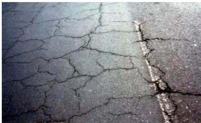
Ilustración 10. Agrietamiento en bloque -Alta severidad.
