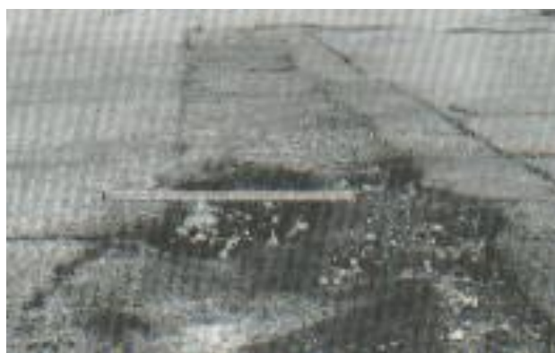
Ilustración 32. . Baches y zanjas reparadas - Alta severidad.
