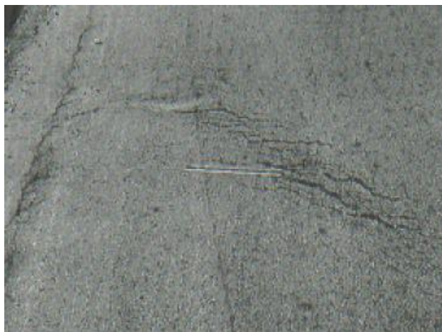
Ilustración 48. Ahuellamiento - Alta severidad.
