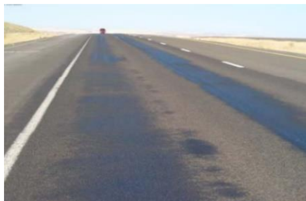
Ilustración 6.Exudación - Media severidad.
