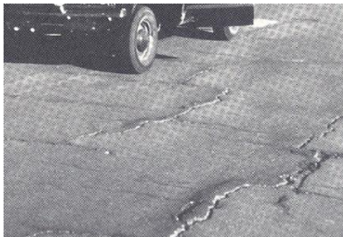
Ilustración 10. Agrietamiento en bloque -Alta severidad.
