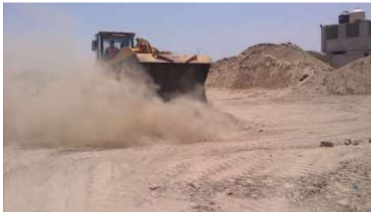
Figura 5. Etapa de dosificación de la mezcla
