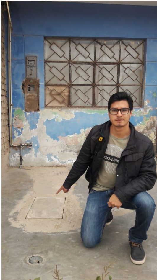
FOTO N°33: Caja de desagüe #02 dentro del lote - Calle Iquitos, a espaldas del Mercado José Quiñones
