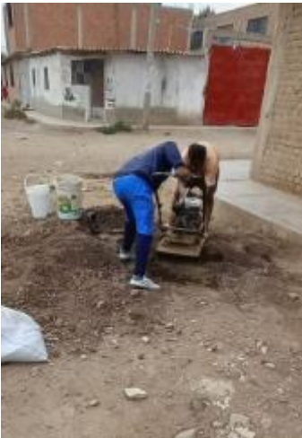
Ilustración 30: Excavación y compactación para el tramo de prueba
