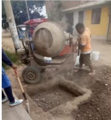
Ilustración 30: Excavación y compactación para el tramo de prueba
