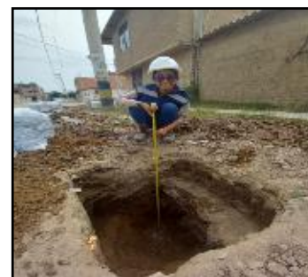
C3: 1.10m de largo, 1.13m de ancho y 1.50m de fondo.
