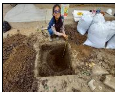
C1: 1.10m de largo, 1.15m de ancho y 1.35m de fondo.
