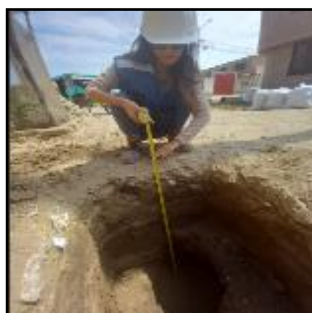
C2: 1.00m de largo, 1.00m de ancho y 1.40m de fondo.
