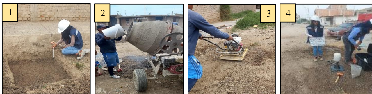
Ilustración 16: Ensayo de densidad de campo.
