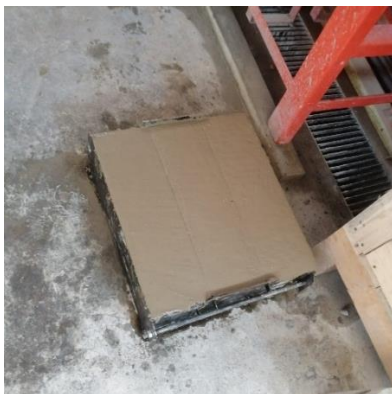
Figura N°29: Vigas de concreto
