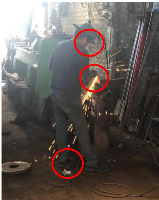
Figura 103. Operarios sin EPP'S expuestos a factores de riesgo
