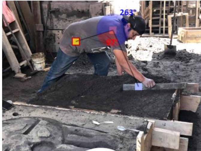
Figura 61. Operario alisando arena del molde Fuente: San Simón S. A. C.
