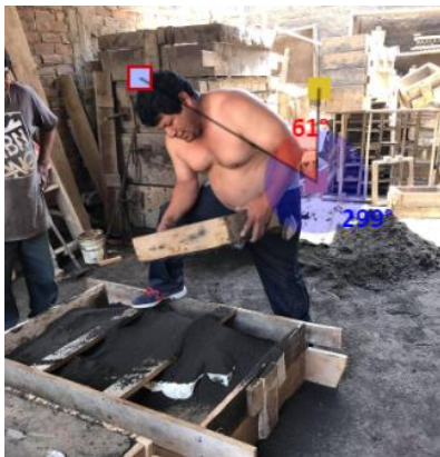
Figura 49. Operario tamizando arena
