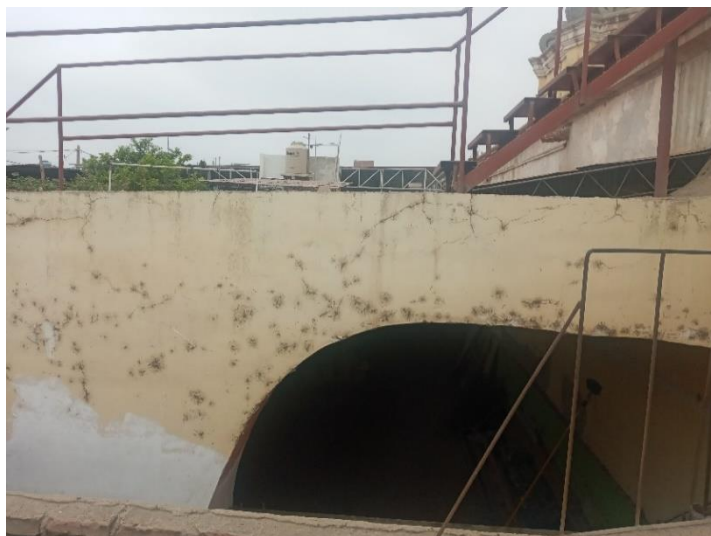
Figura 64. Contrafuertes en muros y cúpulas
