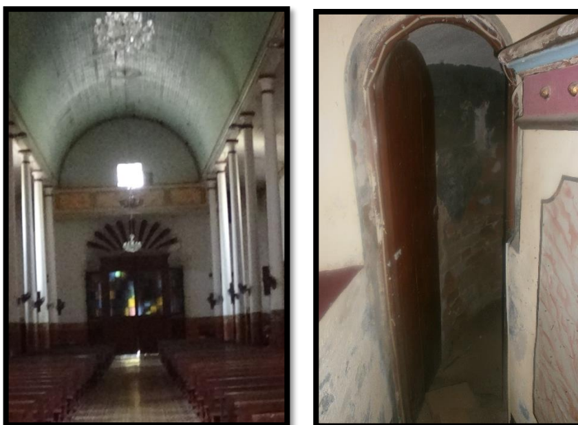
Figura 21. Detalle de entrepisos
