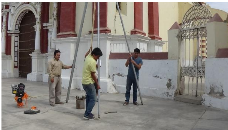
Figura 58. Colocación del equipo SPT en triangulación.
