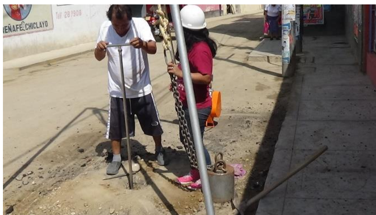
Figura 52. Iniciando los trabajos del ensayo SPT.
