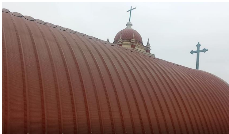
Figura 61. Nave Central hecha de bóveda encamionada de madera pino, recientemente cambiado su cobertura de calamina.
