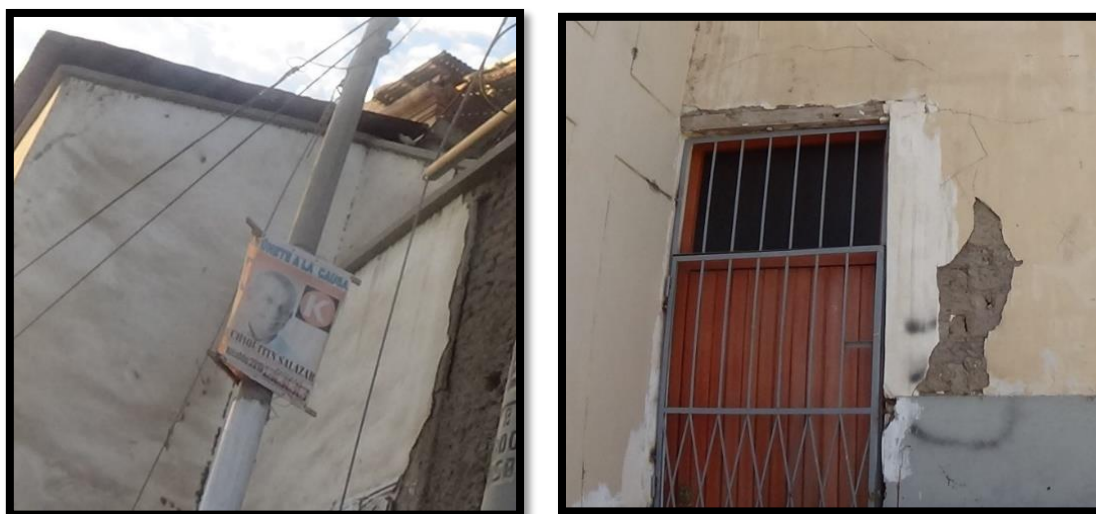
Figura 20. Detalle de muros de adobe.
