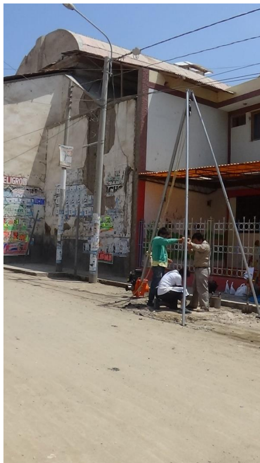
Figura 51. Instalación del equipo para el ensayo SPT en el sondeo N°01.
