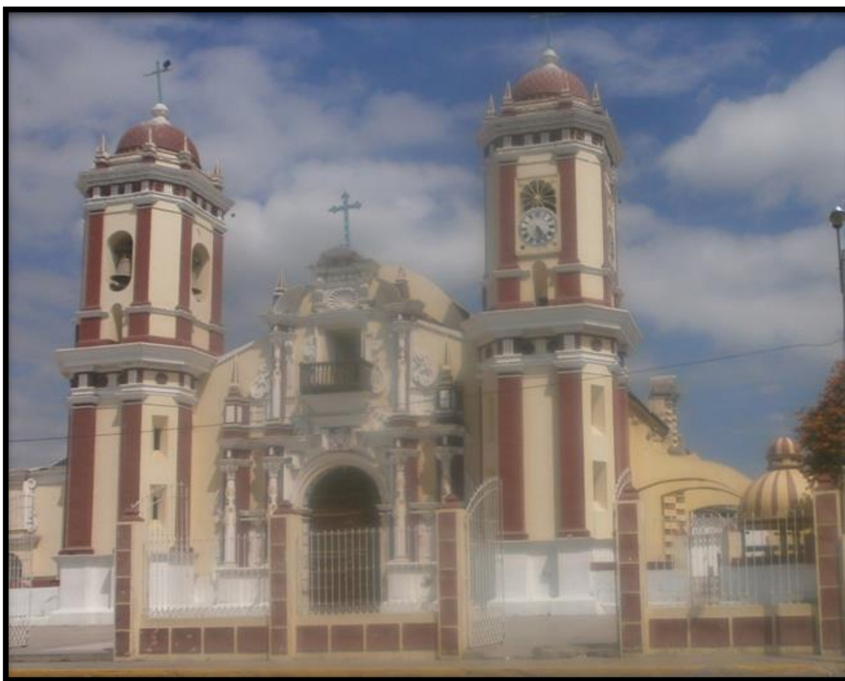
Figura 1. Fachada principal Iglesia Santa Lucía
