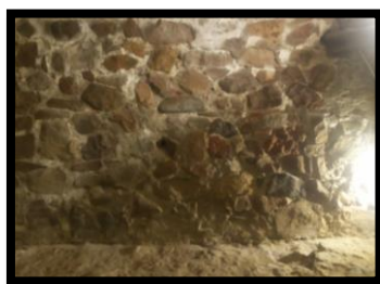
Figura 29. Cimentación de piedra en la iglesia Santa Lucia
