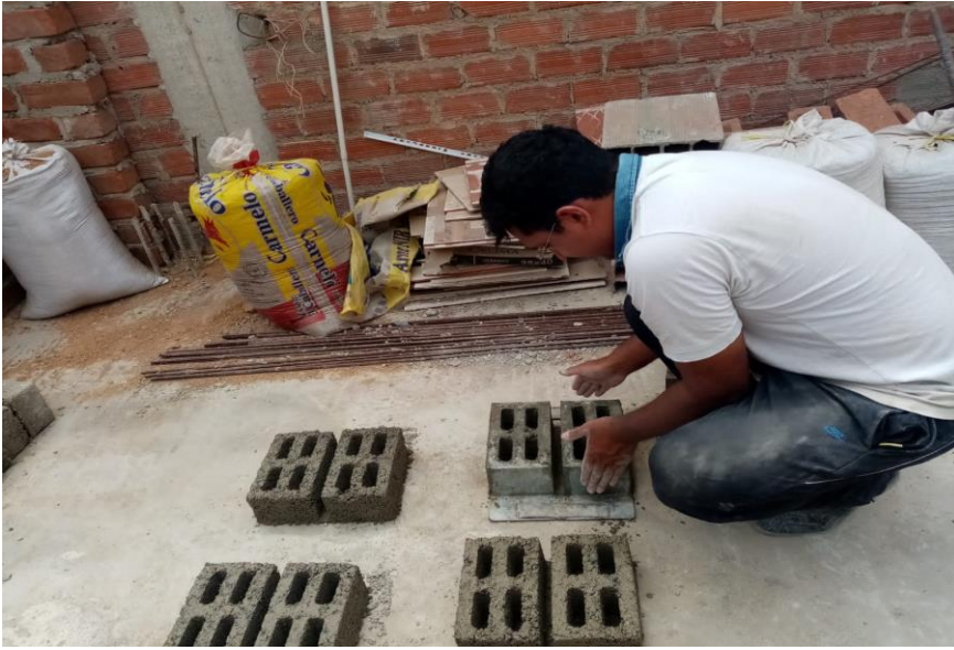
Desmolde del ladrillo
