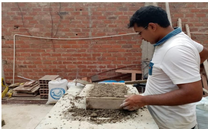
Llenado de la mezcla en el molde
