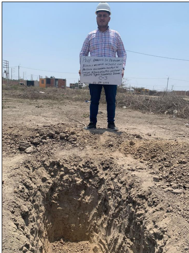
Figura N° 11: Calicata C-3. Fuente: Propia.
