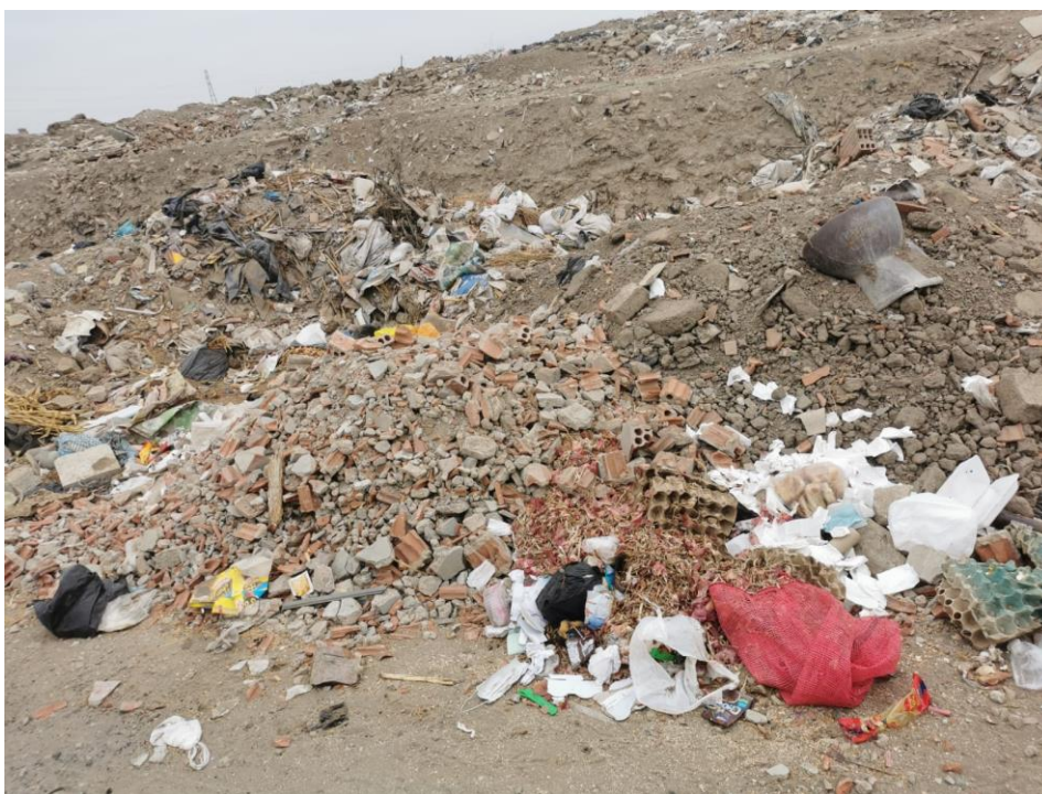
Imagen 38: Imagen de residuos de ladrillo proveniente de demoliciones.
