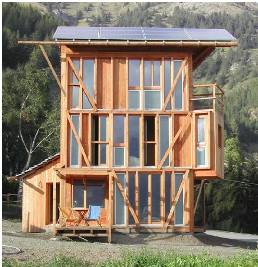
Ilustración n°7: Casa Solare (Fuente : Archdaily)
