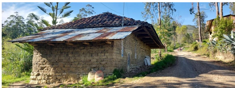
Ilustración n°3: Antiguas viviendas de adobe
