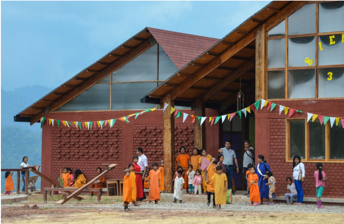
Ilustración n°8: Casa Solare (Fuente : Archdaily)
