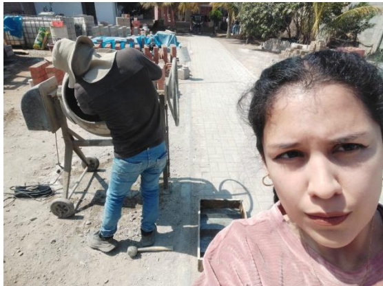
Figura 100: Proceso de vaciado de los moldes en el porcentaje de 1.5% de adición de fibra de acero entrefilado.
