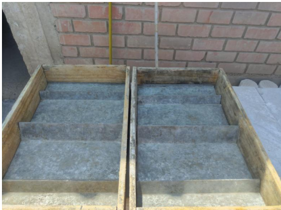
Figura 92: Moldes poseen una dimensión de 0.5*0.36*1m.
