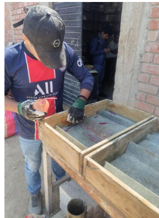
Figura 93: Proceso de colocación del aceite desmoldante.
