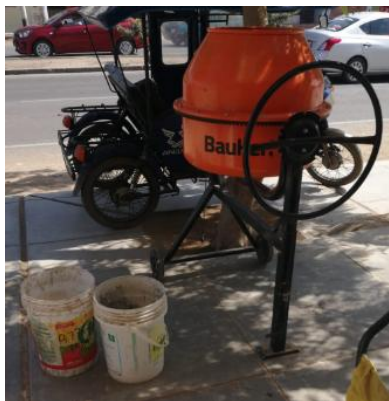
Figura 53: Materiales necesarios para el proceso de mezclado de concreto. Fuente: Elaboración Propia.
