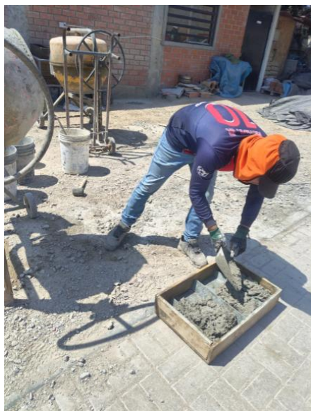
Figura 95: Proceso de llenado de los moldes.
