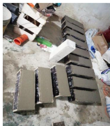
Figura 44: Proceso de llenado culminado de vigas. Fuente: Propia.
