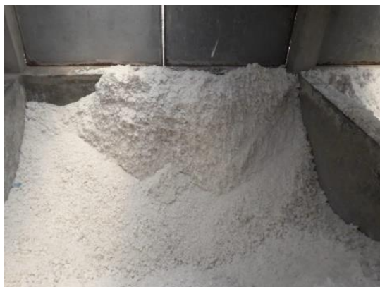
Figura 20. Silos de materia prima
