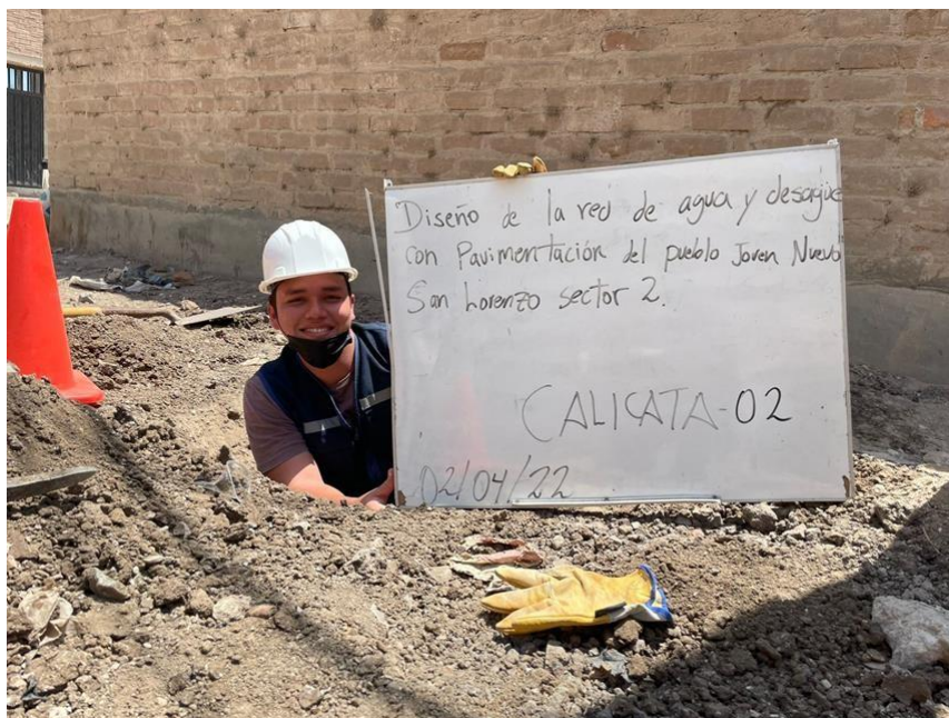
Figura 17 Ejecución de calicata N° 02
