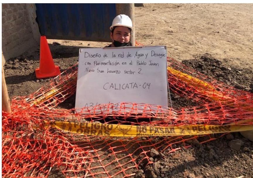
Figura 18 Ejecución de calicata N° 04
