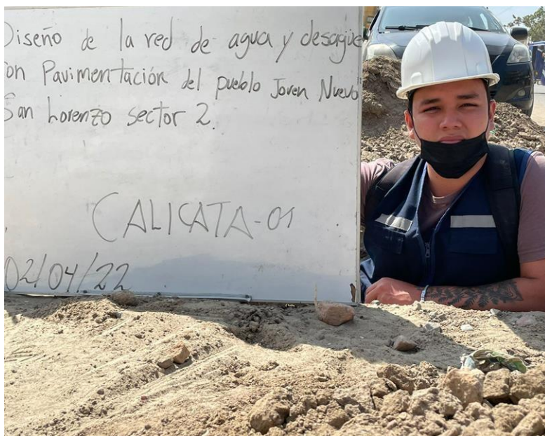
Figura 16 Ejecución de calicata N° 01
