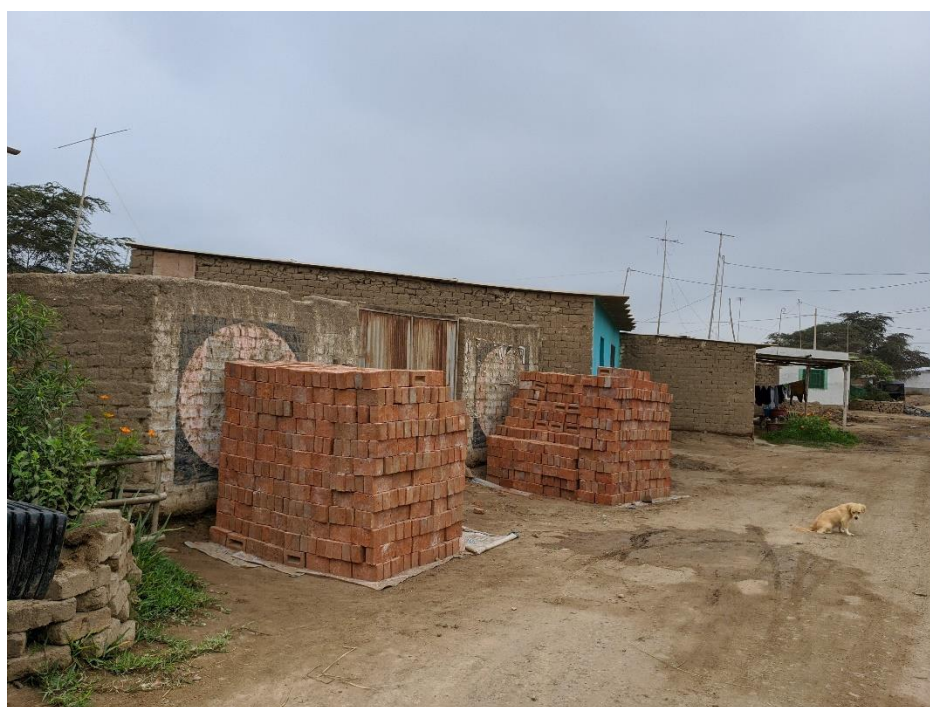
Fotografía 6. Ladrillo que se usará como material de construcción para una vivienda rural
