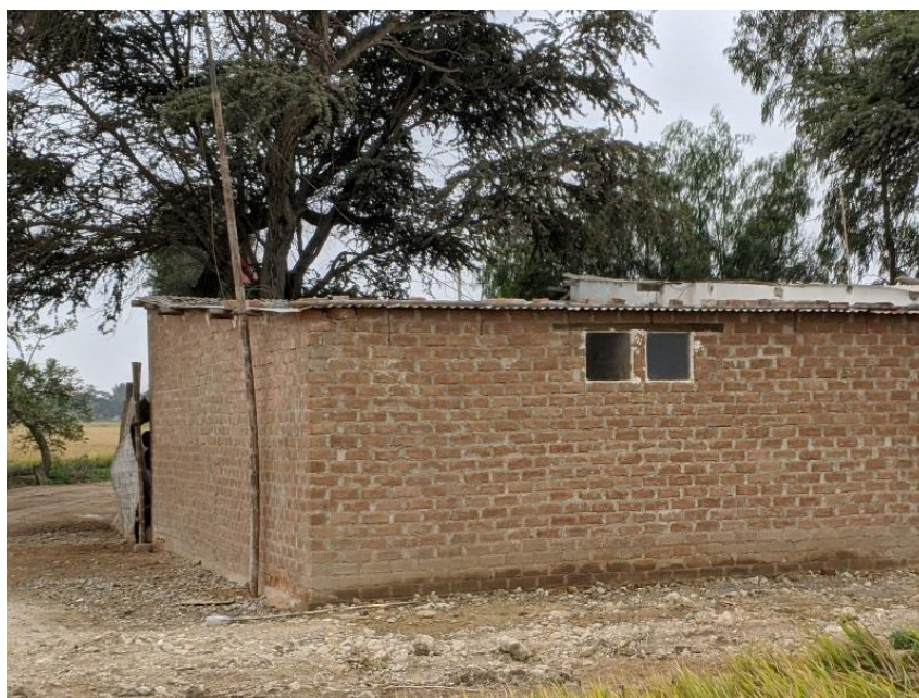
Fotografía 8 Vivienda rural de ladrillo artesanal en Mochumí
