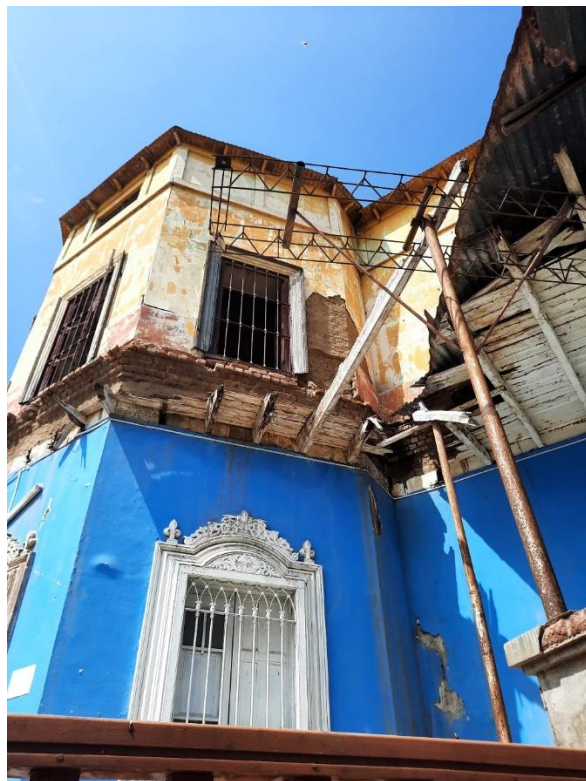
Nota. Visita a campo para el registro del estado actual de la ex Casa hacienda de Batangrade (primera etapa), fecha 1 de mayo de 2023.
