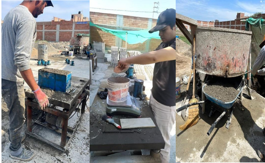
Anexo 11. Fabricación de los bloques de concreto.
