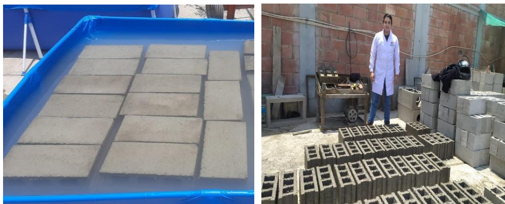
Figura 14. Curación de bloques.
