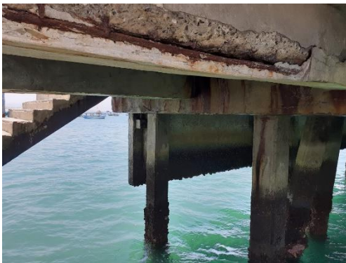
Fotografía 8. Columnas del muelle. Fuente: Elaboración propia.
