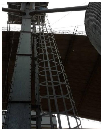
Ilustración 8: Tubo de transporte del elevador de cangilones
