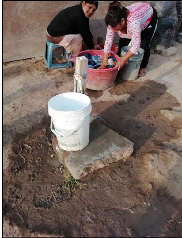
Figura 29. Conexiones clandestinas – Asentamiento Humano “Los Arenales”
