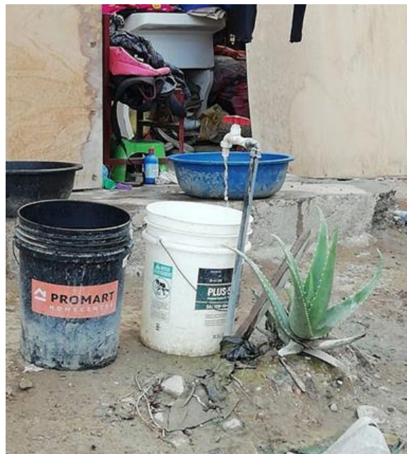
Figura 30. Conexiones clandestinas – Asentamiento Humano “Los Ángeles”
