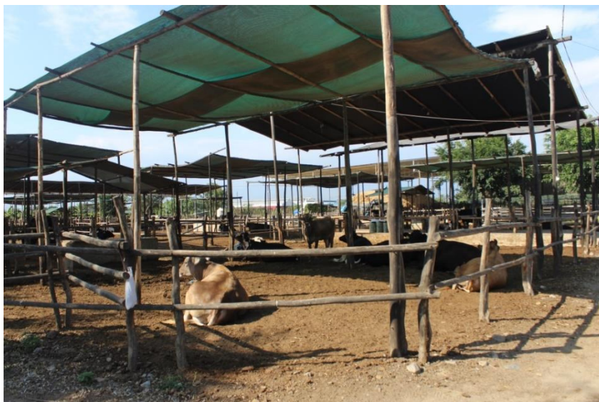
Figura 5. Condiciones estructurales de corrales
