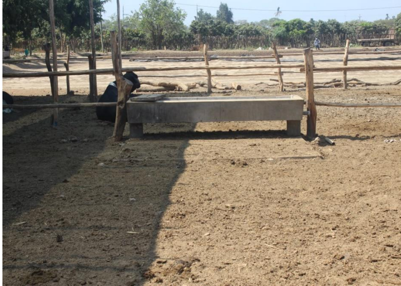
Figura 7. Condiciones estructurales de bebederos
