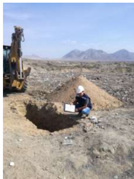
Fuente: Fotografía del propio autor.
