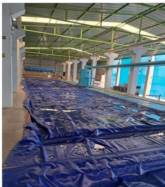
Figura 11. Vista de la poza en la planta
