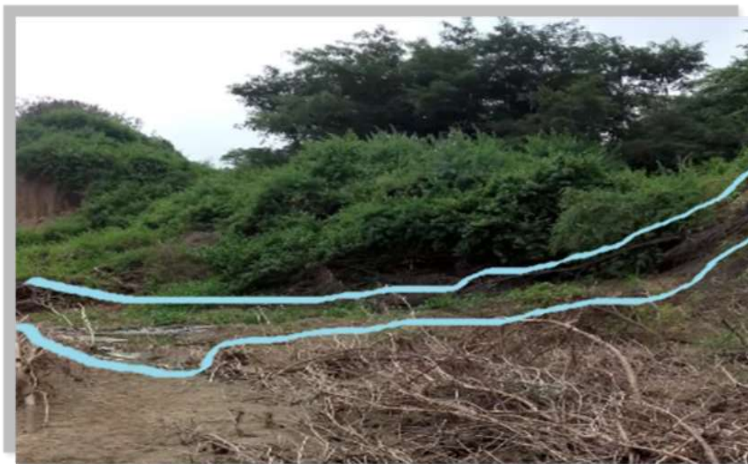
Fotografía N° 3 : Daños en terrenos de cultivo durante fenómeno del niño 2017.
