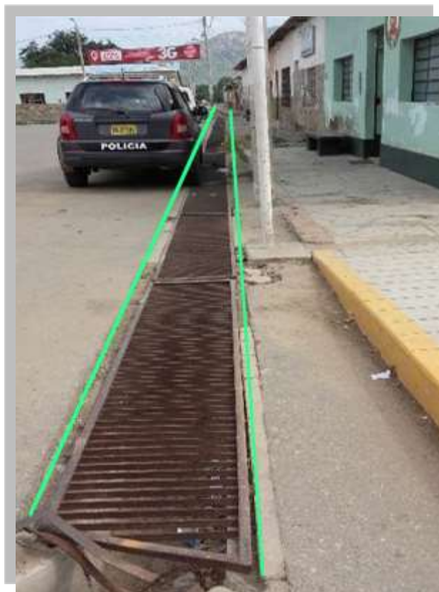
Fotografía N° 10 : Cunetas en mal estado, obstruidas con residuos sólidos.
