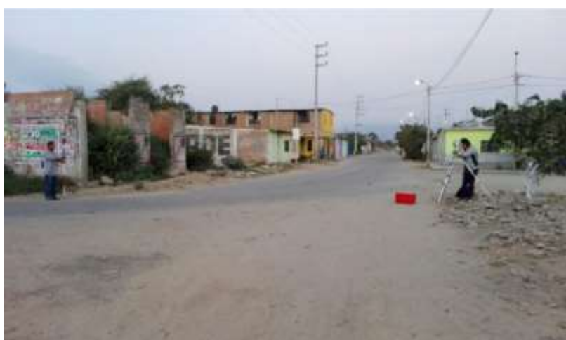
Fotografía N° 23 : Levantamiento topográfico de la calle Dátil.
