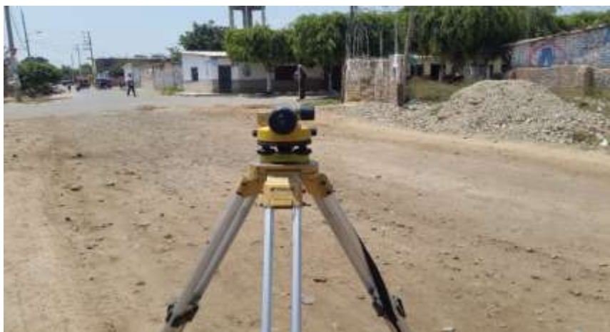
Fotografía N° 27 : Nivelación de la red topográfica.
