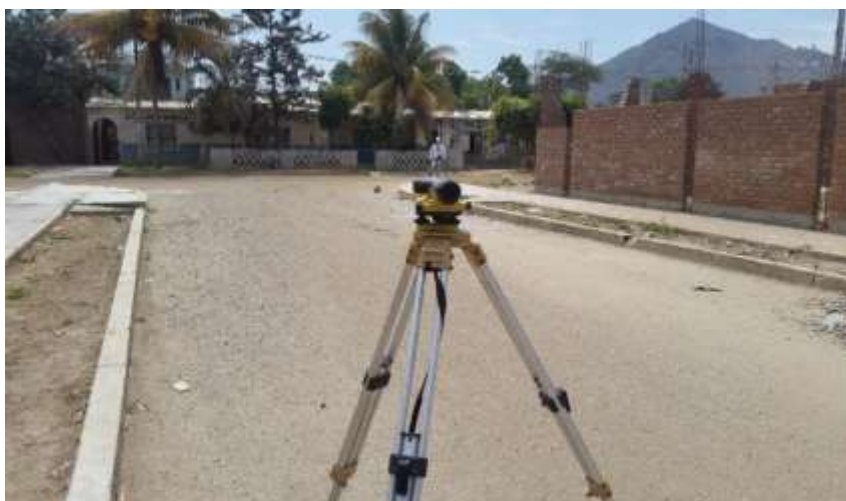
Fotografía N° 29 : Nivelación de BM 22, sector Quinta.
