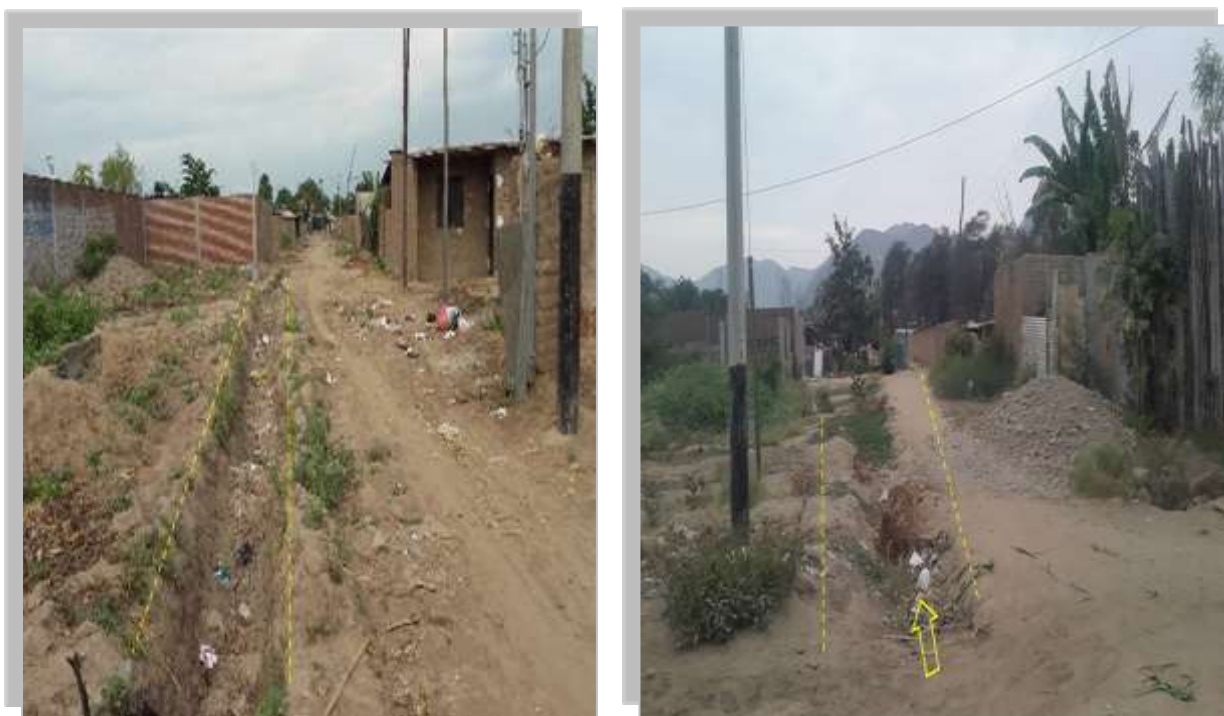
Fotografía N° 8 : Huellas provocadas por el flujo de agua durante las lluvias de marzo, 2017.
