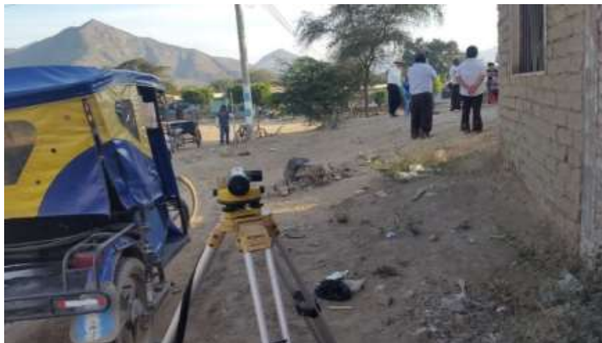
Fotografía N° 28 : Nivelación de BM 19, sector Balsa.
