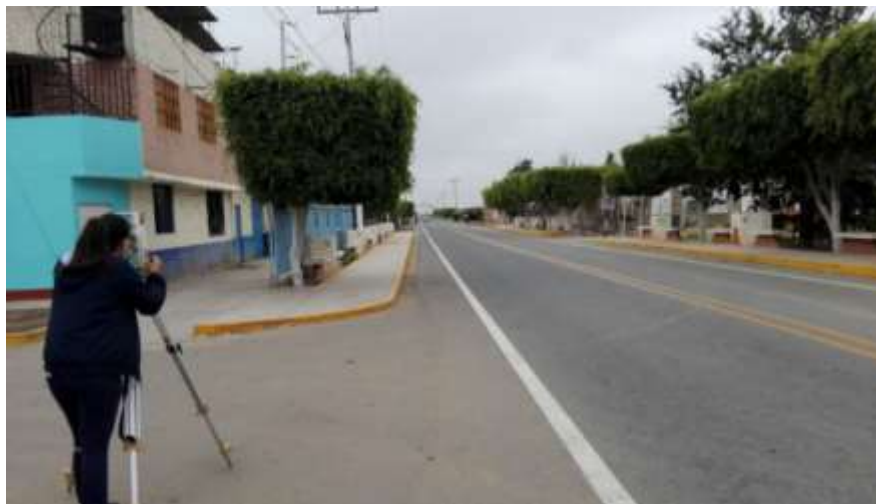
Fotografía N° 25 : Levantamiento de sección de vía, calle Real.
