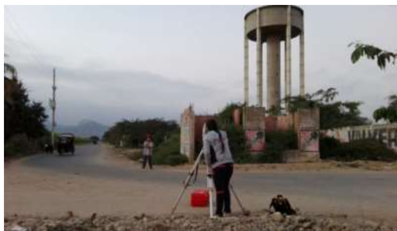
Fotografía N° 24 : Levantamiento topográfico de la sección de vía.
