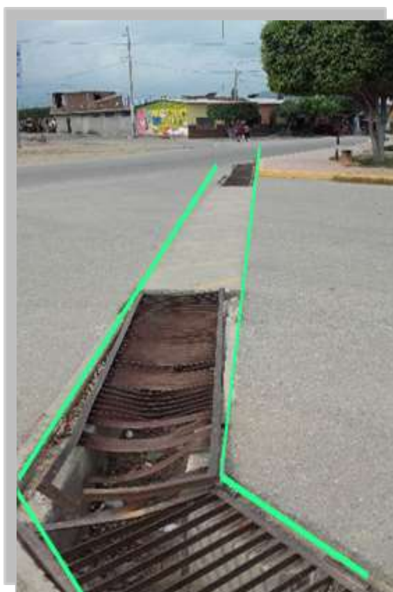
Fotografía N° 10 : Cunetas en mal estado, obstruidas con residuos sólidos.
