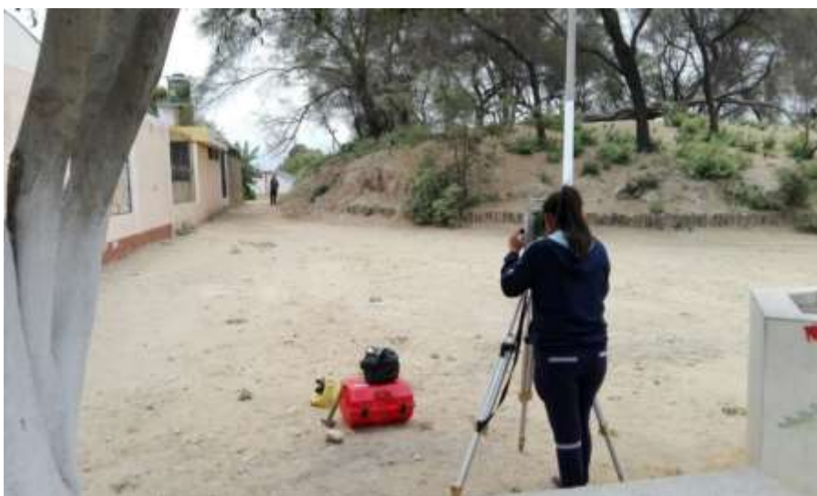
Fotografía N° 26 : Levantamiento topográfico en el sector los Mangos.
