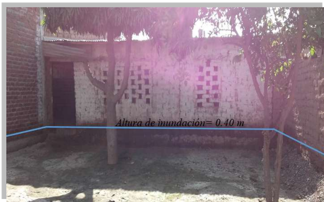
Fotografía N° 4 : Viviendas inundadas durante las lluvias, marzo 2017
