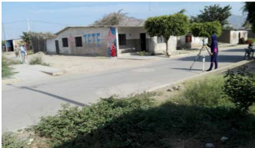
Fotografía N° 20 : Levantamiento Topográfico de la calle Los Algarrobos.
